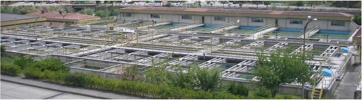
Şekil 1.1. Trabzon içme suyu arıtma tesisi (ATASU)
