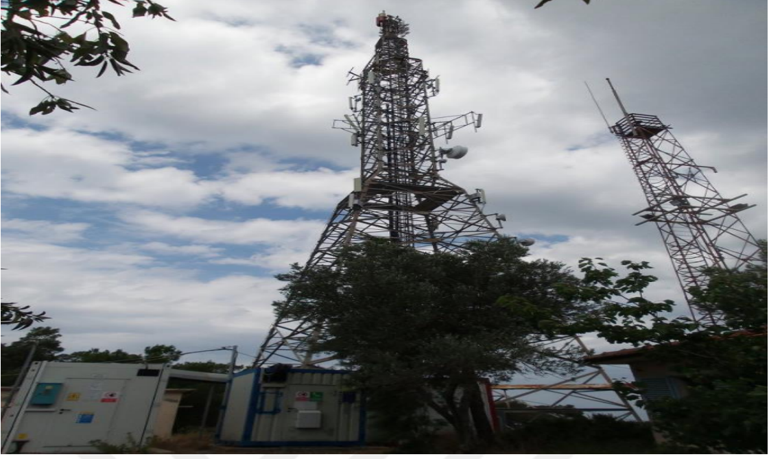
Şekil 17. Gerçek bir kırsal makro hücre yapısı örneği [62].
