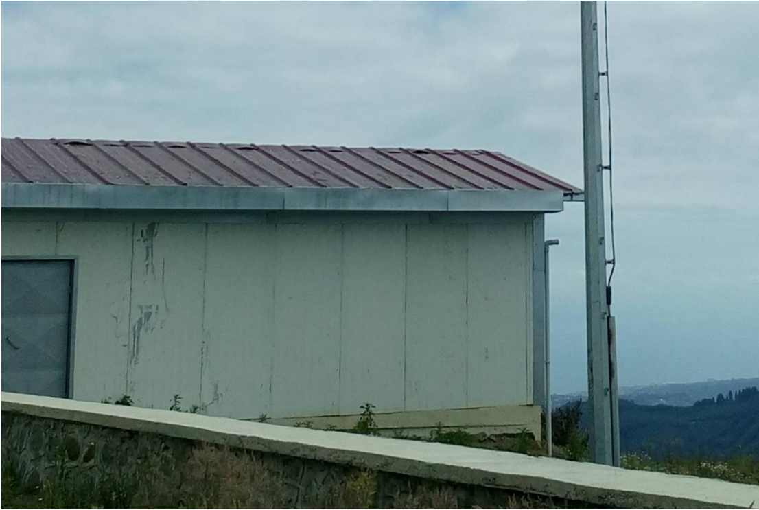
Şekil 31. Karakaya içme suyu grubu mikro HES santral binası
