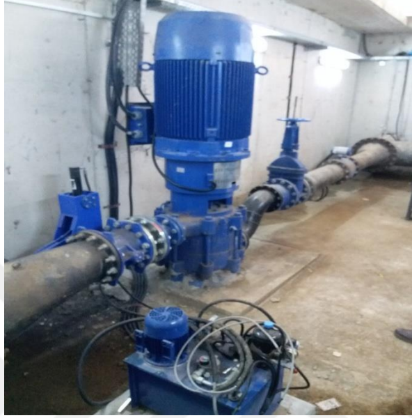
Şekil 11. Karakaya (Ağıllı) mikro HES' inde kullanılan PaT sistemi
