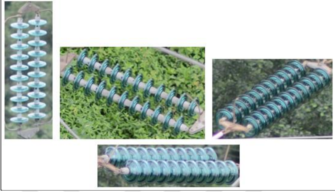
Şekil 2.5. Üçüncü sınıfımız olan "sağlam_cam" etiketini kullandığımız sağlam cam izolatörlerden bazıları
