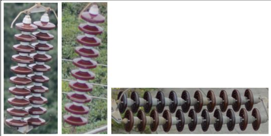
Şekil 2.6. Dördüncü sınıfımız olan "sağlam_pors" etiketini kullandığımız sağlam porselen izolatörlerden bazıları
