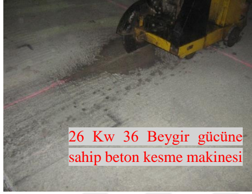
Şekil 2.7. Beton plakta yarım derzlerin kesimi
