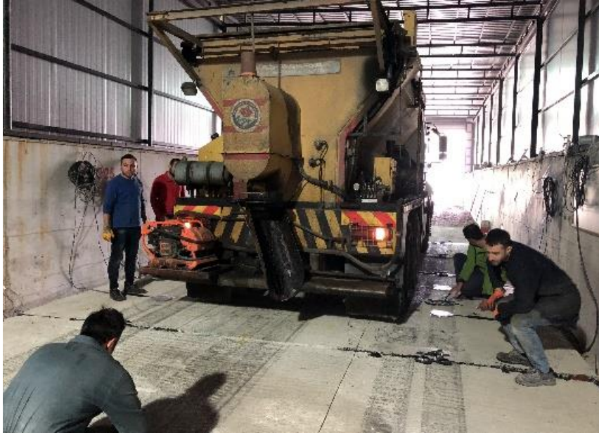
Şekil 2.59. Robot ile asfalt dökümü sırasında ölçüm cihazlarına özen gösterilerek yapılan çalışma
