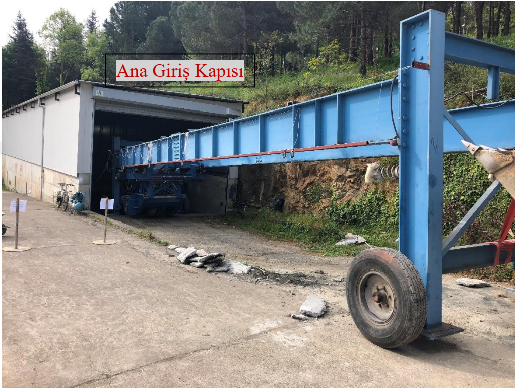
Şekil 2.2. Yükleme cihazının asfalt kaplama yapılması için ana kapıdan dışarıya çıkarılması
