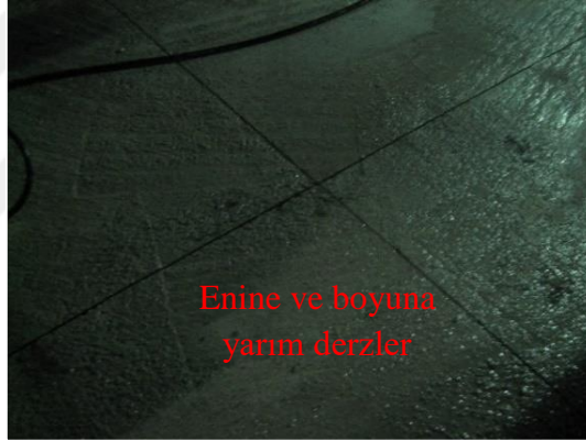
Şekil 2.8. Kesme temizlik işleminden sonra derzler
