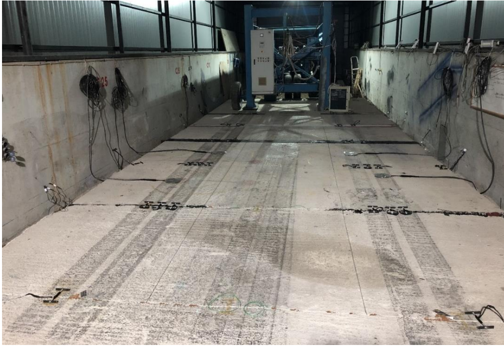
Şekil 2.53. Asfalt içinde kalacak bütün ölçüm cihazları yerleştirildikten sonraki hali
