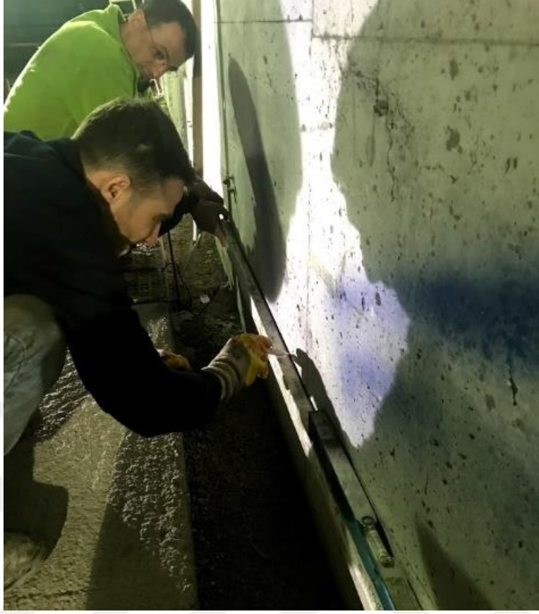
Şekil 2.58. Asfalt kalınlığını ayarlamak için sabit duvara yapılan kotlama çalışması
