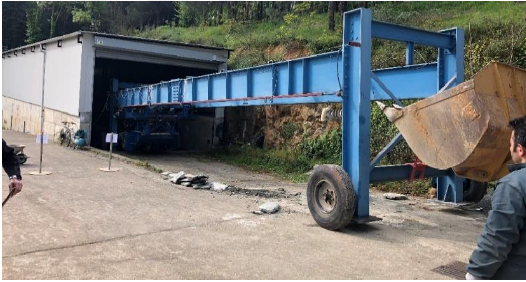
Şekil 2.57. Asfalt kaplamanın yapımı için sistemin dışarıya çıkarılması
