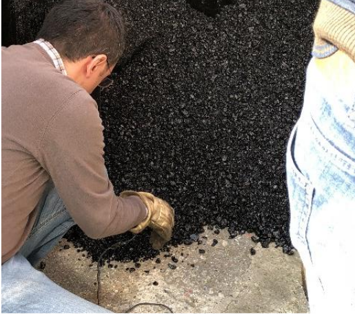
Şekil 2.45 Cihazların yerleştirilmesi Şekil 2.46. Finişer ile asfalt dökümü
