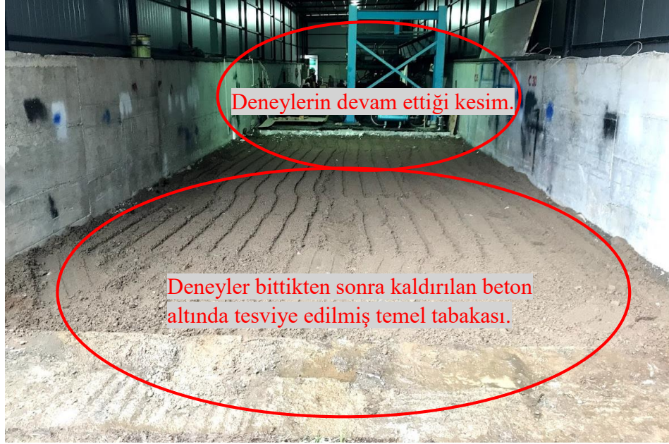
Şekil 2.5. Tesisin önceki çalışmalarında kullanılan beton kaplamanın altında bulunan temel tabakası
