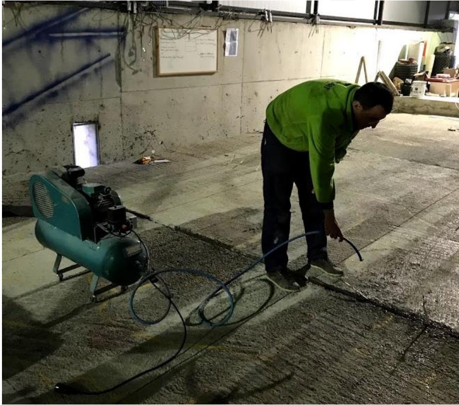
Şekil 2.31. Tazyikli hava ile plaka ve derz içlerinin temizlenmesi işlemi
