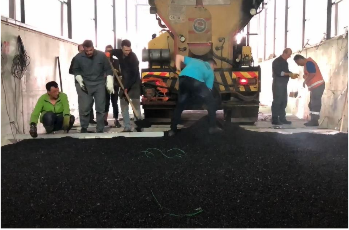
Şekil 2.60. Tesisin içerisine asfalt kaplama yapımı
