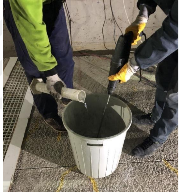
Şekil 2.34. Harç için kullanılan malzemeler Şekil 2.35. ve harcın hazırlanışı
