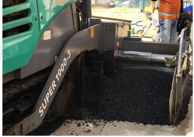
Şekil 2.45 Cihazların yerleştirilmesi Şekil 2.46. Finişer ile asfalt dökümü
