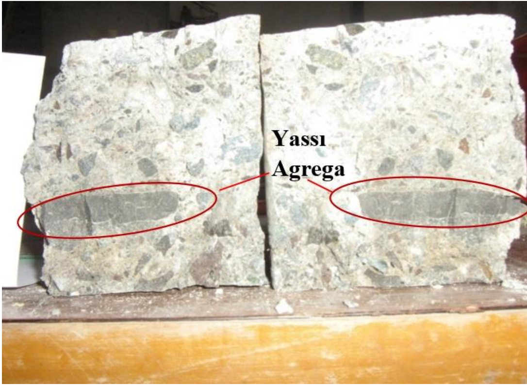
Şekil 1.12. Trabzon İlinde beton yollardan alınan numunelerde görülen yassı agrega
