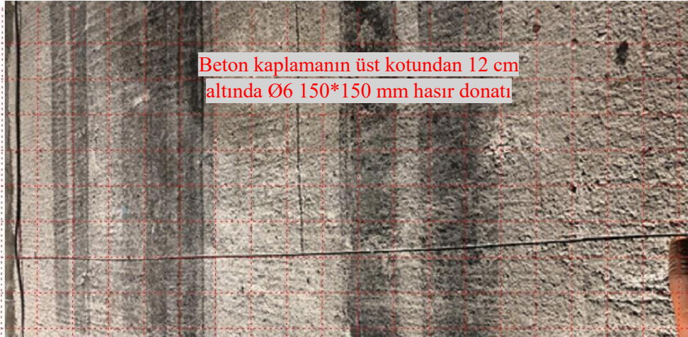
Şekil 2.32. Hasır çelik donatılı plaklar ve yarım derzler
