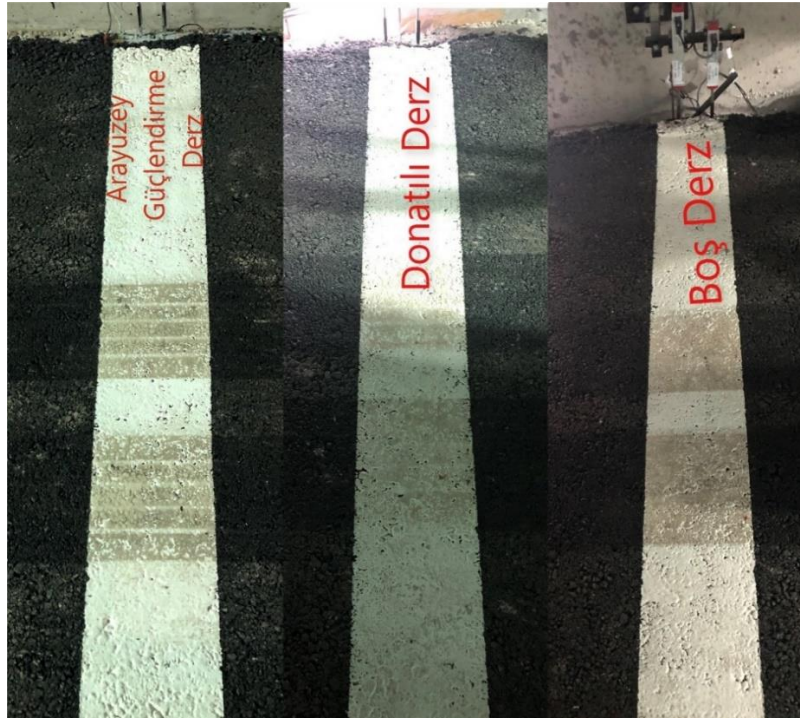
Şekil 3.38. 8 cm asfalt kaplamada 100,000 yüklemde oluşan tekerlek izi
