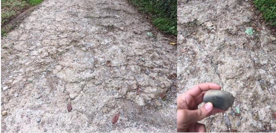
Şekil 1.25. İyidere Kalecik Köyü, işçiliği vatandaşlar tarafından yapılan, en az 25 yıldır hizmet veren, tasarımda kırılmamış (pürüzsüz) ve iri agrega oranı yüksek olarak üretilmiş beton yol
