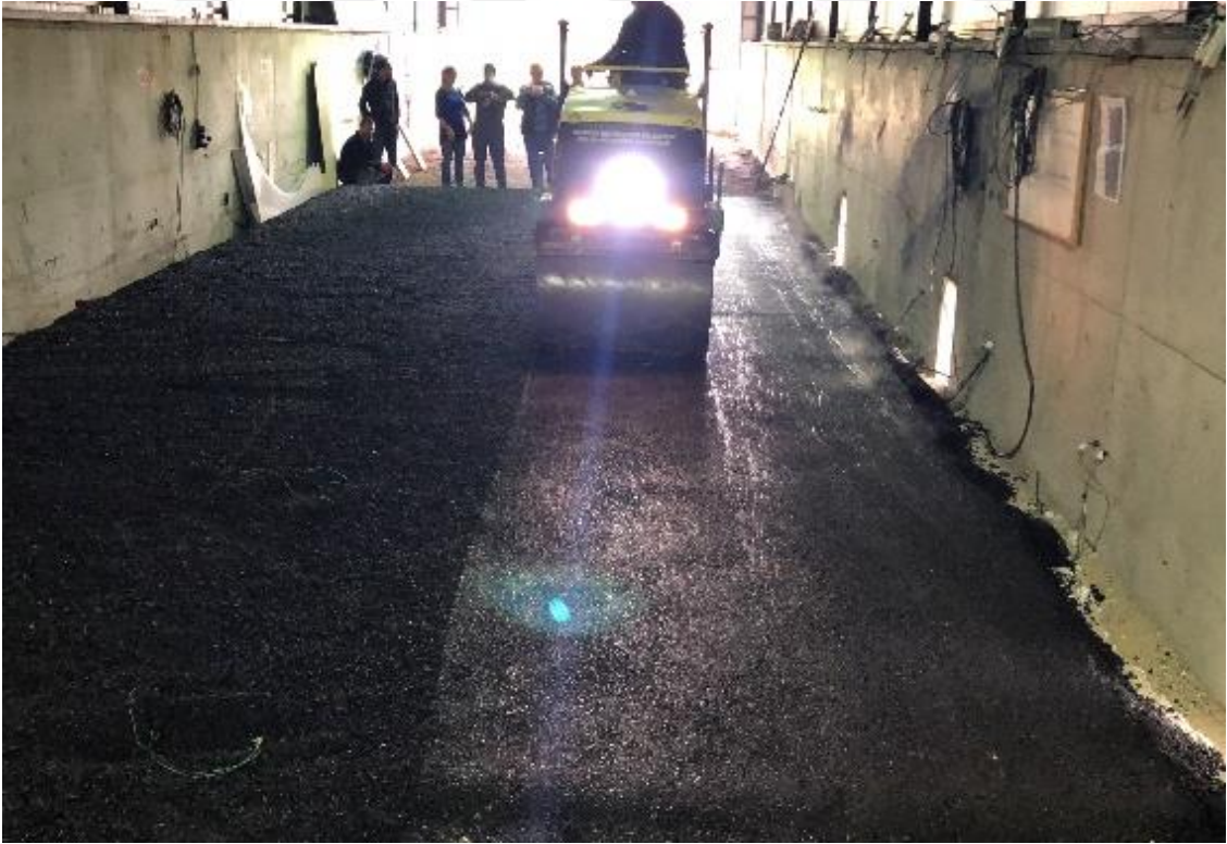
Şekil 2.61. Tesisin içerisinde asfaltın sıkıştırılması
