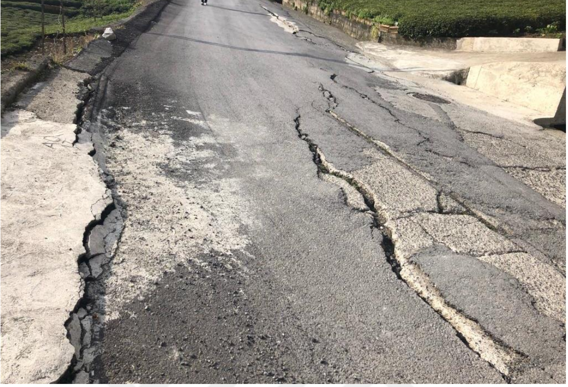
Şekil 1.10. Dernekpazarı Zincirlitaş Mah. alttemelde drenaj eksikliği nedeniyle kaymalar
