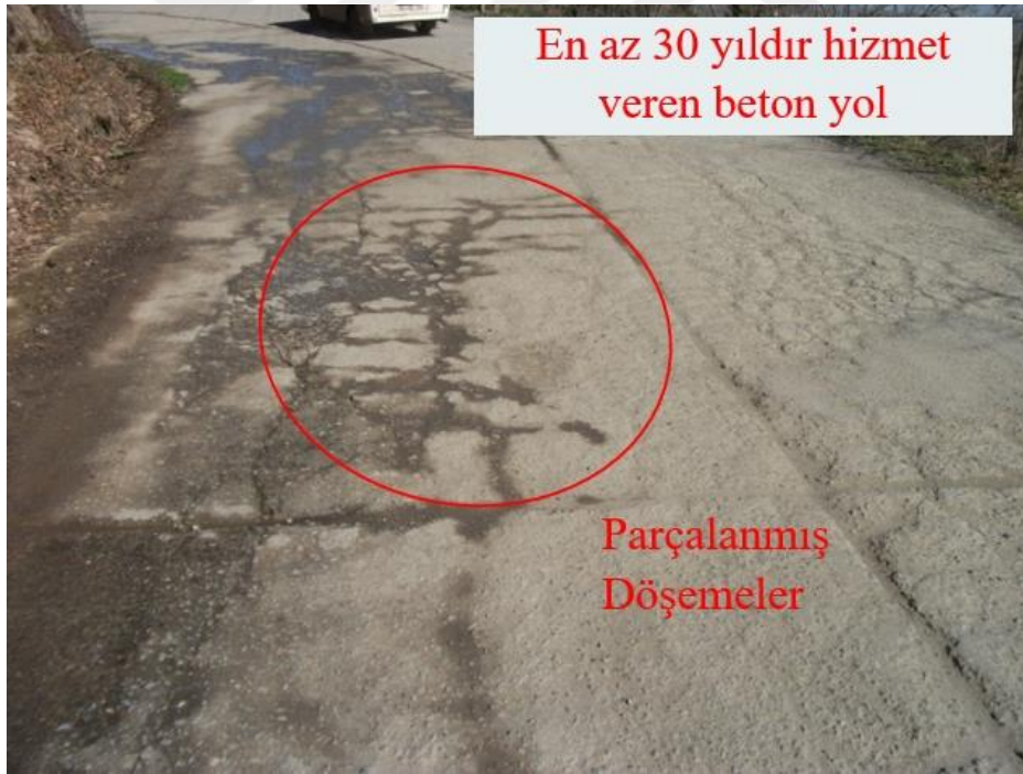
Şekil 1.16. Ortahisar Kavala Mah. parçalanmış plak, enine ve boyuna çatlaklar
