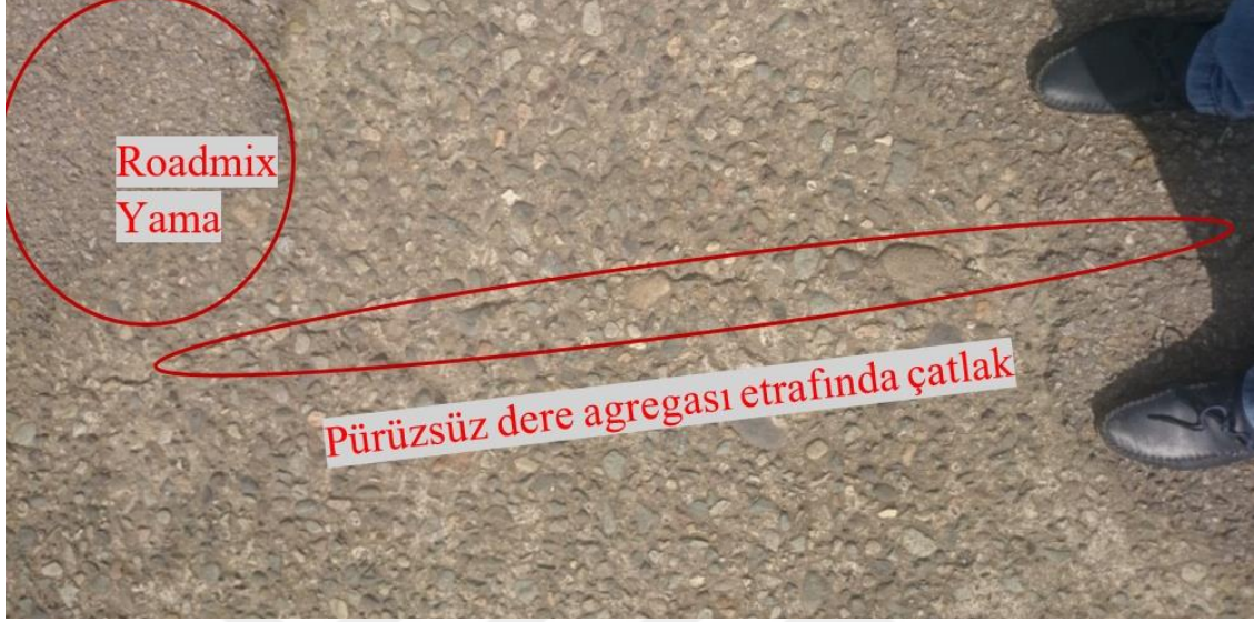
Şekil 1.13. Of Kavakpınar Mah. cilalanma nedeniyle emniyetsiz sürüşe neden olan yol
