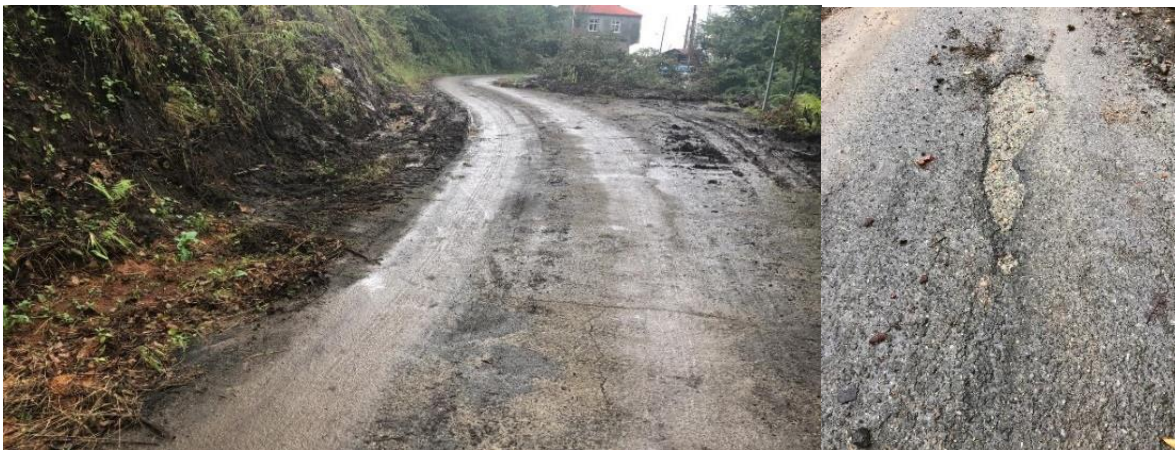
Şekil 1.21. Vakfikebir, Şenocak Mah. dolan yol kenarı hendeği yüzünden, 2-3 cm kalınlığında yapılmış BÜİAK plakları arasına giren su ve yolda yaşanan kopmalar
