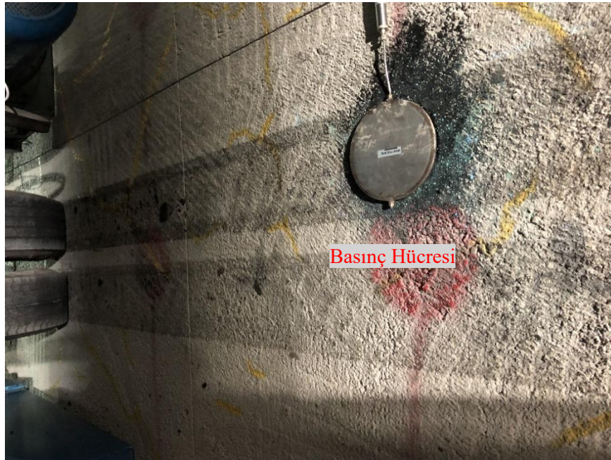
řekil 2.21. Basınç hücrelerinin altına toz kauçuk dökülmesi.
