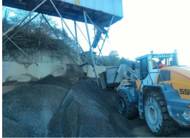
Şekil 3. Beton santrali konkasöründe beton parçalarının öğütülmesi
