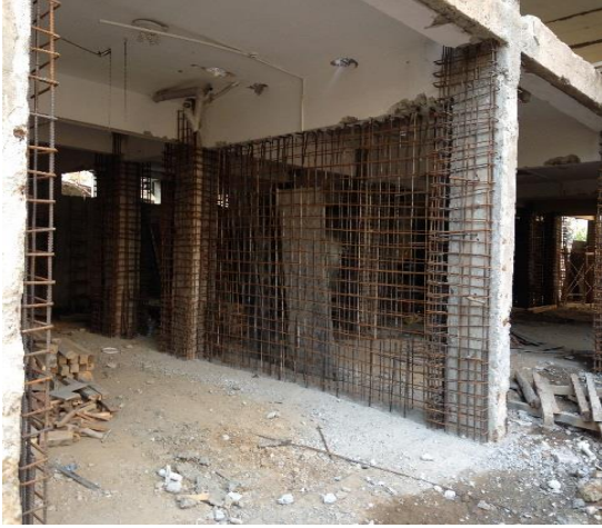
Şekil 1.8. Mevcut binaya eklenen betonarme perdeler
