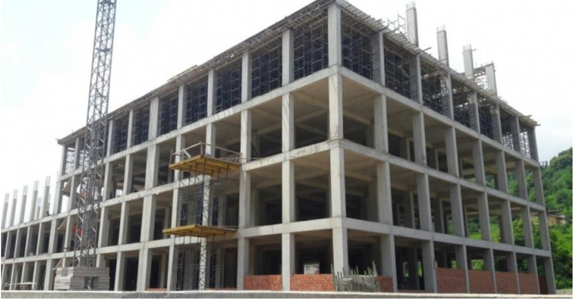
Şekil 1.2. Betonarme bir binanın elemanları
