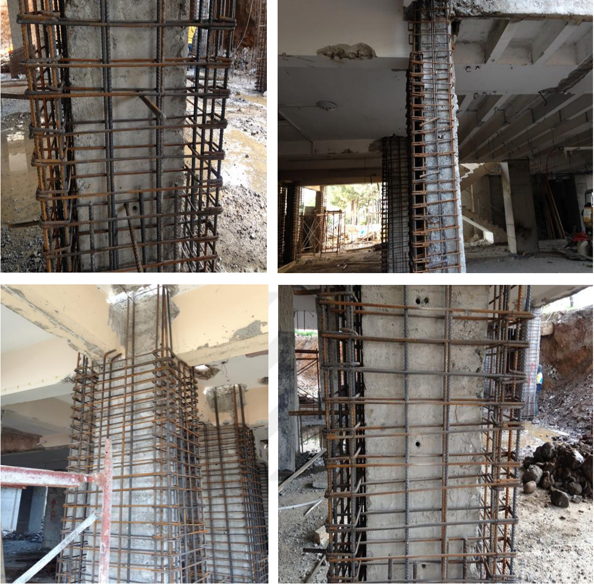
Şekil 1.7. Kolon mantolanmasına ait örnekler
