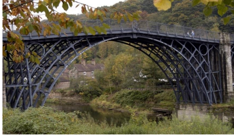
Şekil 1.3. Dünyanın ilk döküm demir köprüsü (URL-2, 2012)
