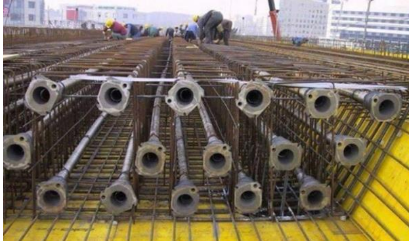
Şekil 1.9. Ardçekme yöntemi
