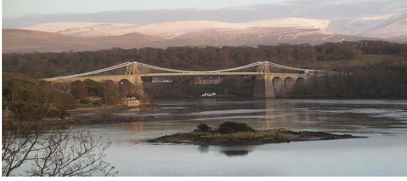
Şekil 1.5. Menai Strait Köprüsü (URL-4, 2014)
