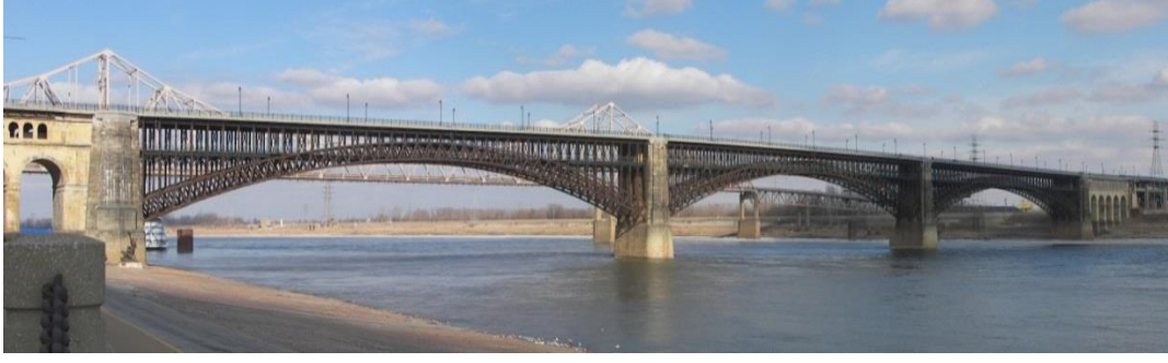
Şekil 1.4. Eads Köprüsü (URL-3, 2009)
