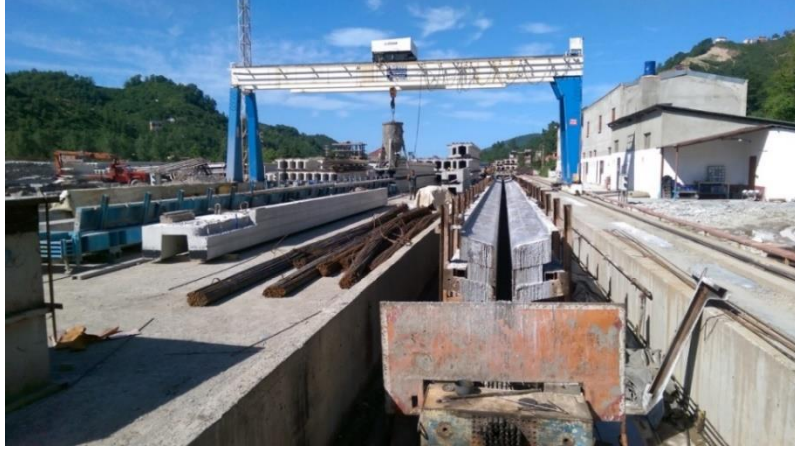
Şekil 1.8. Prefabrik kiriş üretim tesisi
