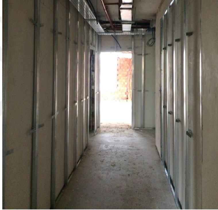
Şekil 22. İç duvarlara alçıpan kaplama yapılması
