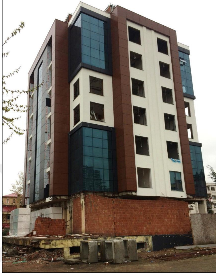
Şekil 18. Tadilat çalışmaları devam ederken otel binası
