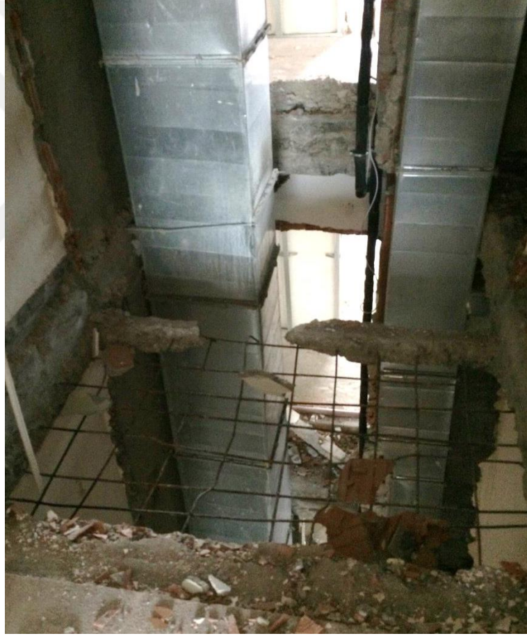
Şekil 21. Tesisatı yapabilmek için yerinde gerçekleştirilen çözüm
