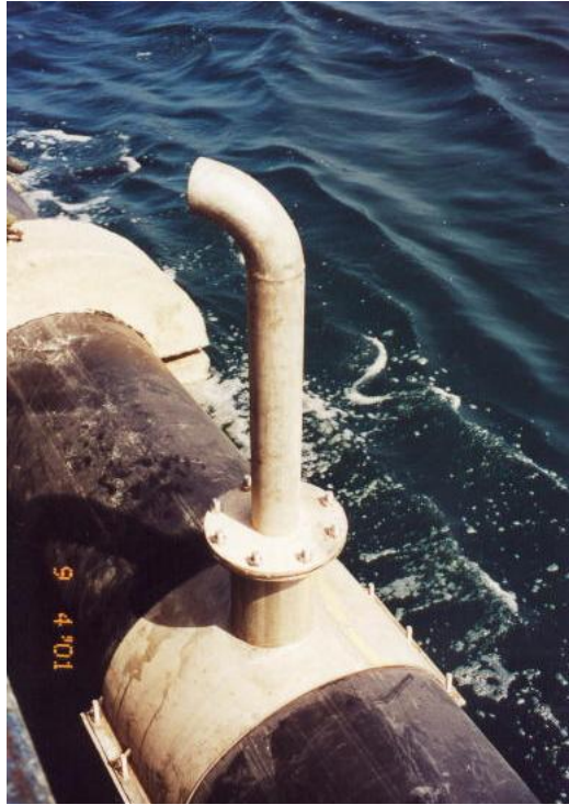
Őekil 11. Deřarj borularına eklenen difzrler (Cořer, 2001).
