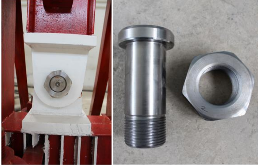
Şekil 2.46. Mafsallı birleşim ve 50 mm çapındaki bulon
