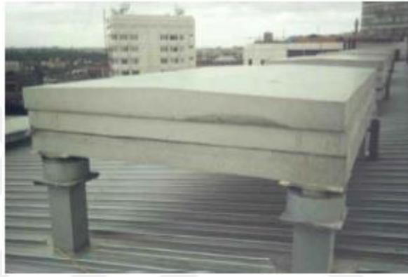
Şekil 1.32. Çatı katında kullanılan bir ayarlı kütle sönümleyicisi
