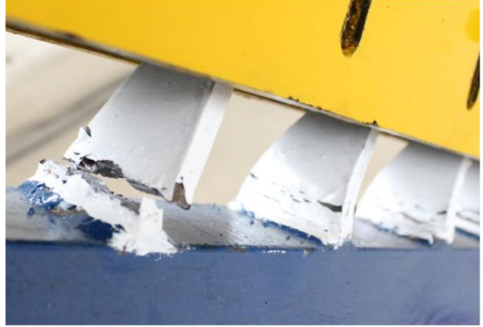
Şekil 3.5. T10' da meydana gelen kopma ve diğer levhalardaki çatlaklar
