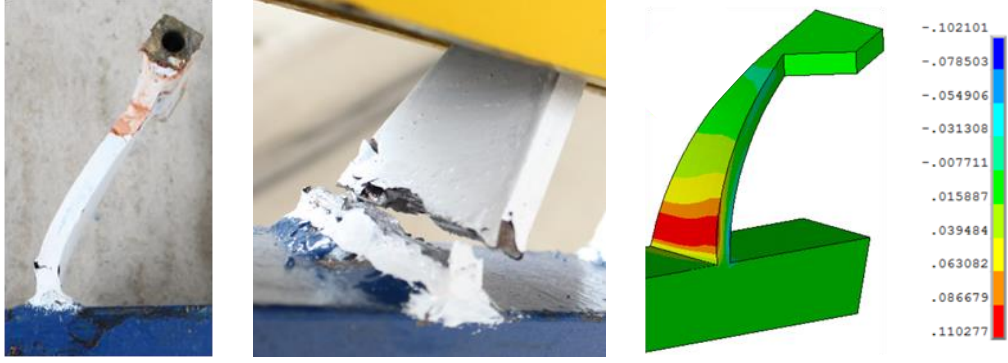
Şekil 3.38.TTSES8 elemanında sönümleyici levhadaki göçme durumu
