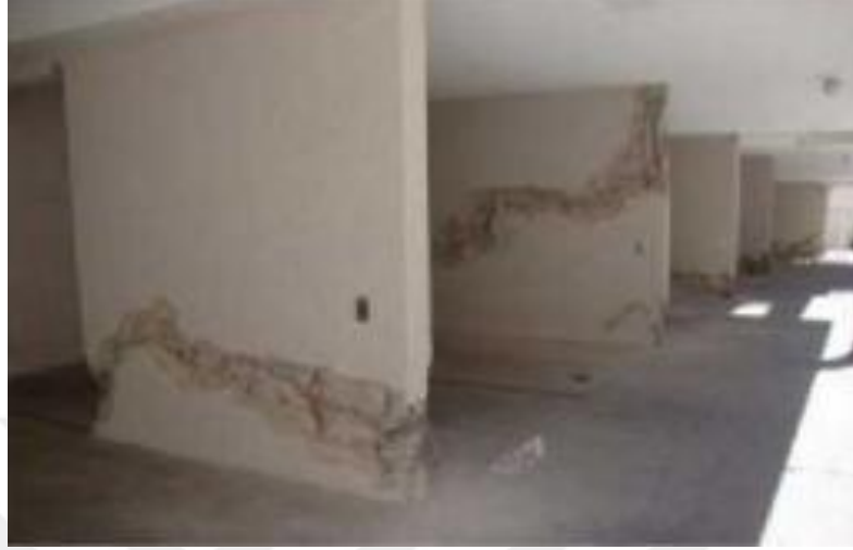
Şekil 1.5. 2010 Şili depreminde yatay kesme kırılmasına maruz perde duvarlar (Wallace vd., 2012)
