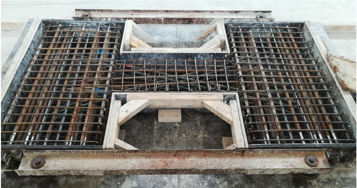
Şekil 2.35. Sargılı diyagonal donatılı bağ kirişi deney elemanı kalıp işlerinin tamamlanması
