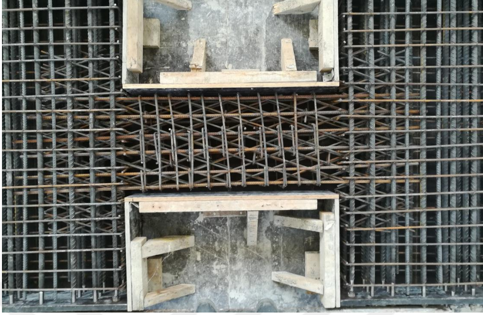
Şekil 2.51. Hasır donatılı (19° açılı) bağ kirişi deney elemanı kalıp işlerinin tamamlanması
