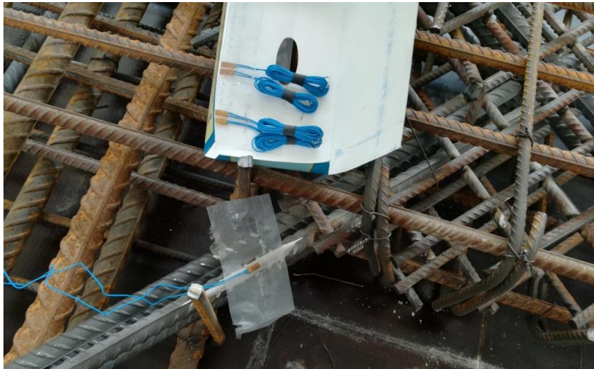
Şekil 2.64. Birim şekil değiştirme ölçerlerin yerleştirilmesi
