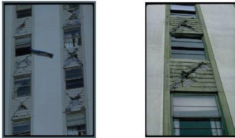
Şekil 1.18. 1964 Alaska depreminde hasar gören bağ kirişi örnekleri (Suen, 2012)
