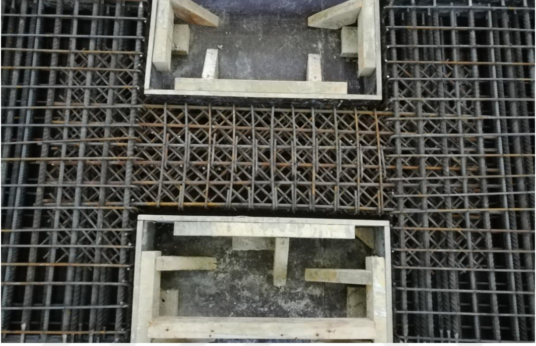
Şekil 2.58. Hasır donatılı ( 45^\circ açılı) bağ kirişi deney elemanı beton dökümü öncesi son hali
