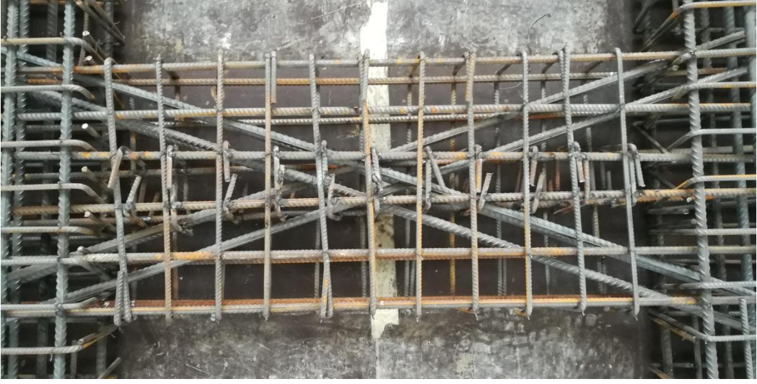
Şekil 2.39. Sargısız diyagonal donatılı bağ kirişine ait donatı düzenlemesi
