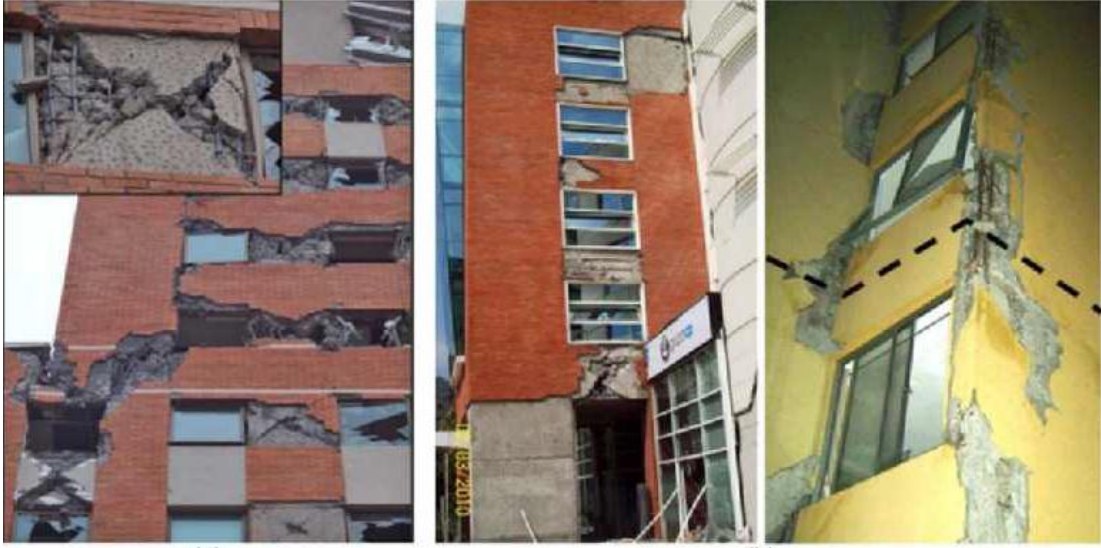
Şekil 1.12. 2010 Şili depreminde hasar gören boşluklu perde duvar ve elemanları (Wallace vd., 2012)
