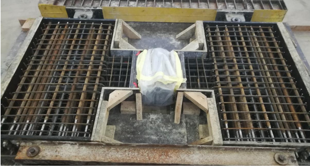
Şekil 2.114. TETOD deney elemanı beton dökümü öncesi görüntüsü
