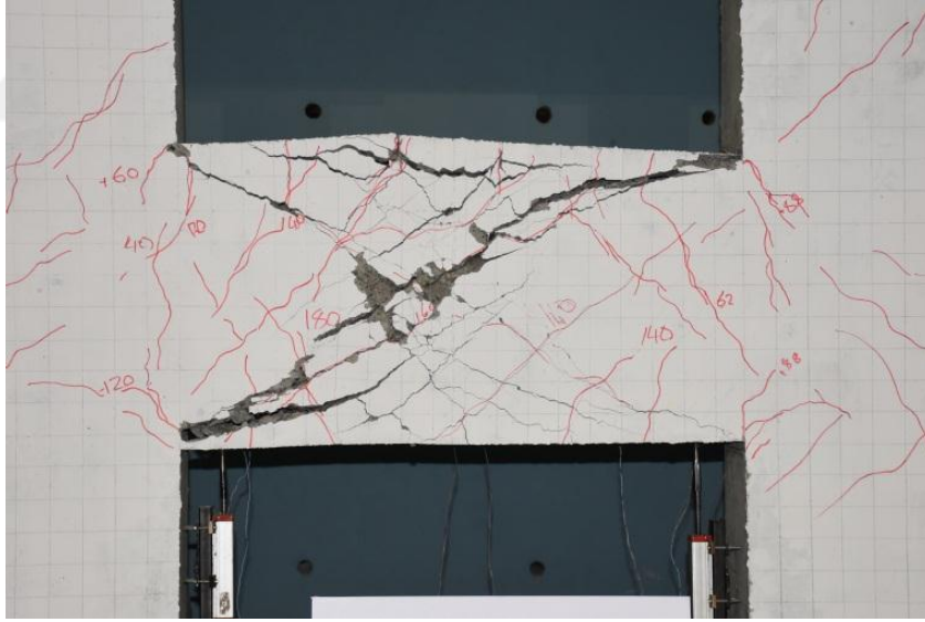
Şekil 3.2. Köşegenlerin üst ve alt kısımlarında kalan betonların parçalanması ve dökülmesi
