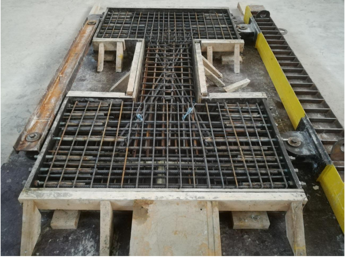
Şekil 2.40. Sargısız diyagonal donatılı bağ kirişi deney elemanının beton dökümü öncesi son hali
