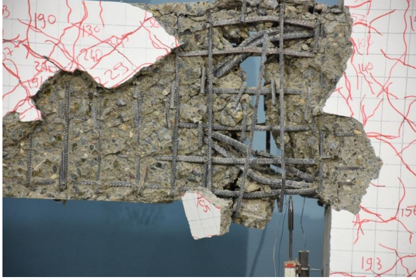
Şekil 3.18. Nihai hasar sonrası diyagonal donatılarda burkulma ve kopma
