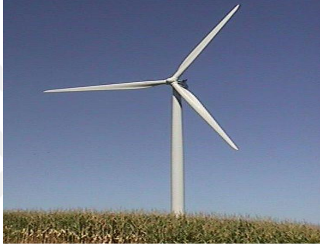
Şekil 1.44. Yatay eksenli rüzgar türbini
