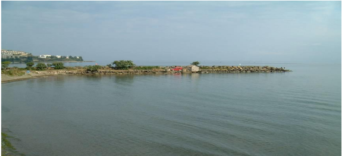
Şekil 37. Araştırma enstitüsü çekek yerinin görünüşü
