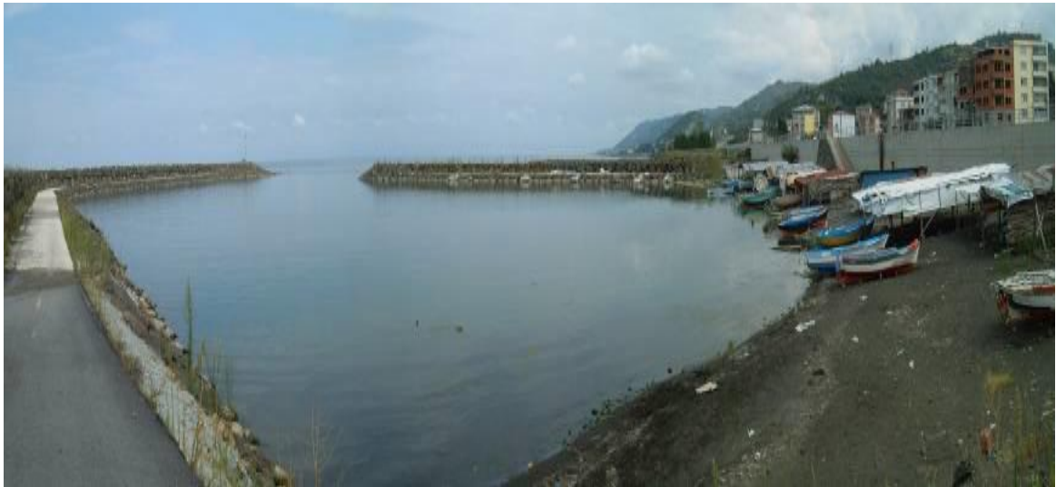
Şekil 51. Yalıköy çekek yerinin görünüşü
