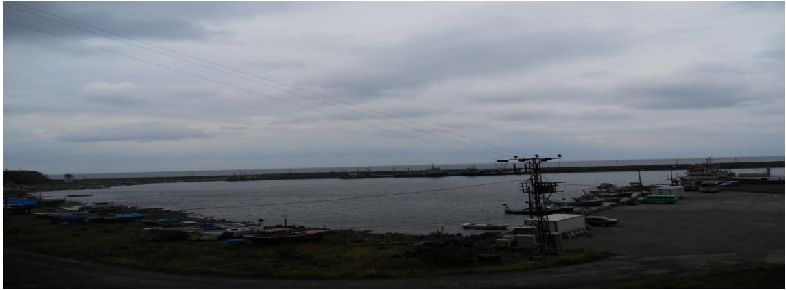
Şekil 21. Yoroz balıkçı barınağının görünüşü
