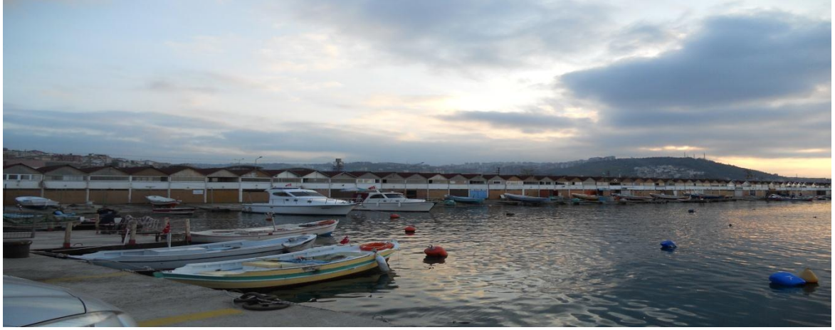
Şekil 15. Trabzon balıkçı barınağının görünüşü
