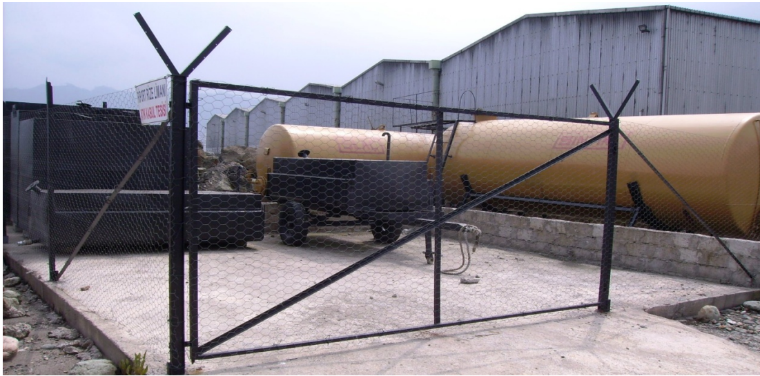
Şekil 8. Rize Limanı atık kabul tesisi
