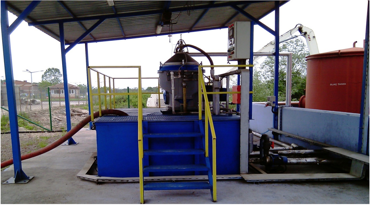
Şekil 18. Ünye Limanı CPI yağ seperatörü
