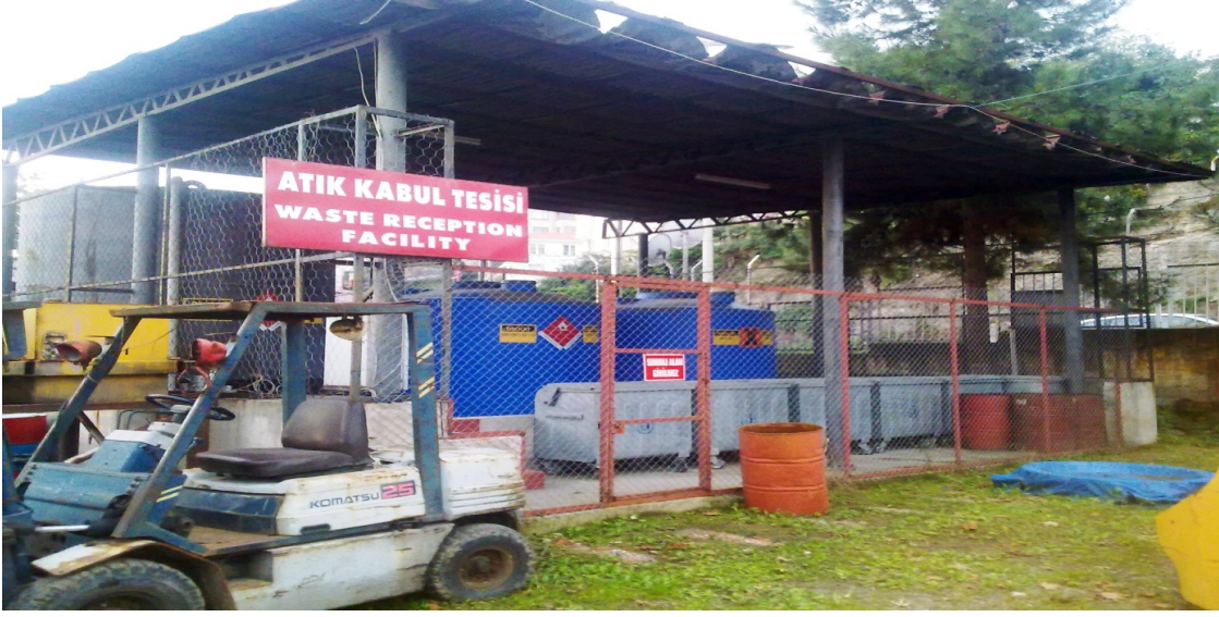
Şekil 15. Ordu Limanı atık kabul tesisi
