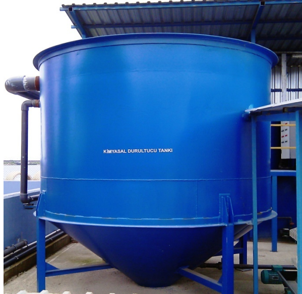
Şekil 21. Kimyasal durultucu tankı
