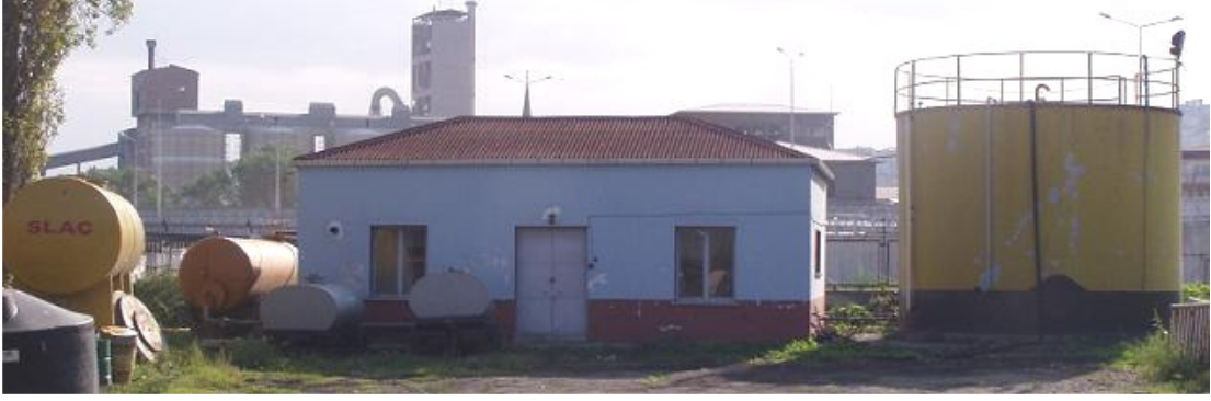
Şekil 6. Sintine suyu arıtma tesisinin dış görünüşü
