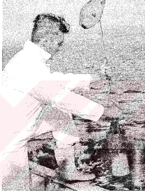
Şekil 2.2. AANDERA - RCM 9 CTD ve akıntı metre ile suyun fiziksel özelliklerinin ölçülmesi
