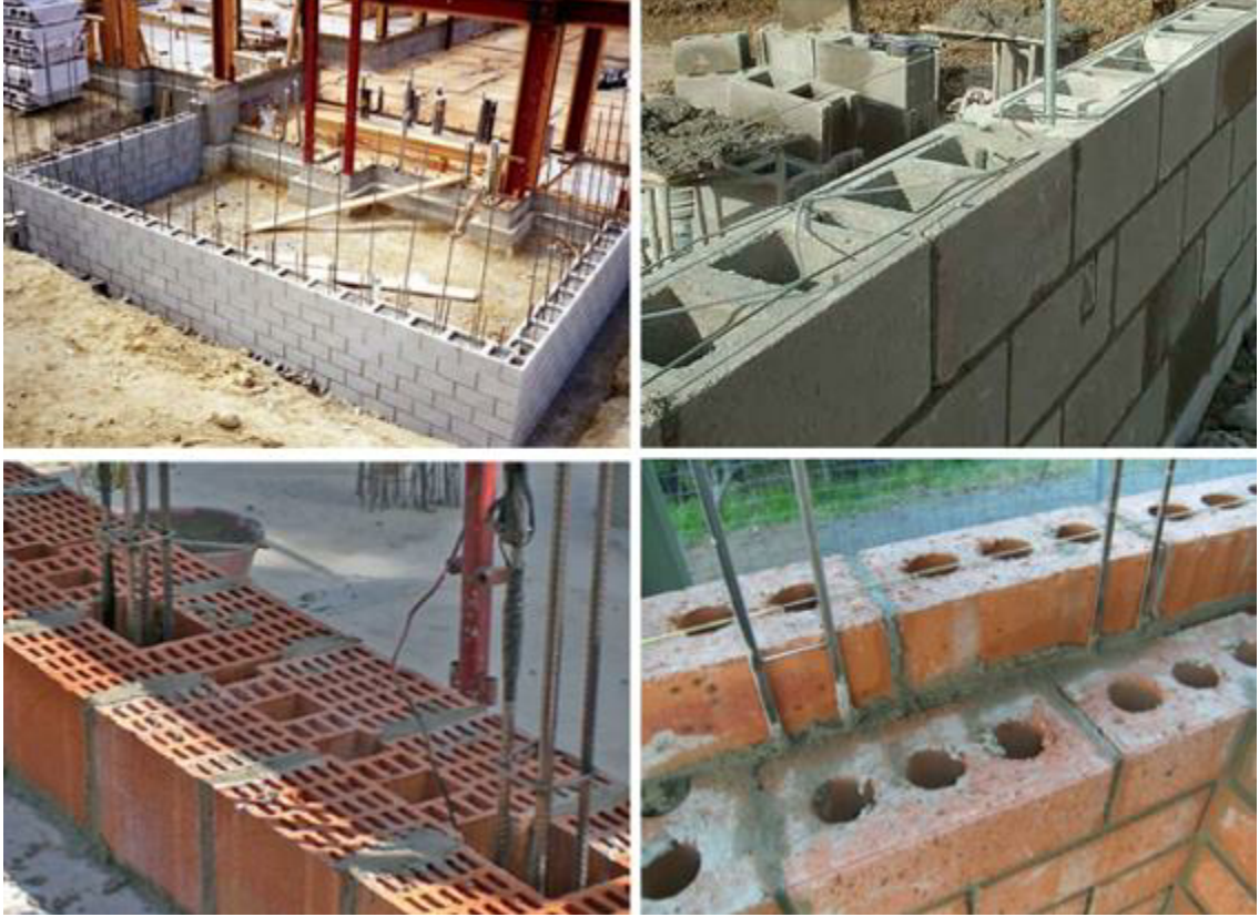
Şekil 1.11. Donatılı yığma yapı uygulamaları
