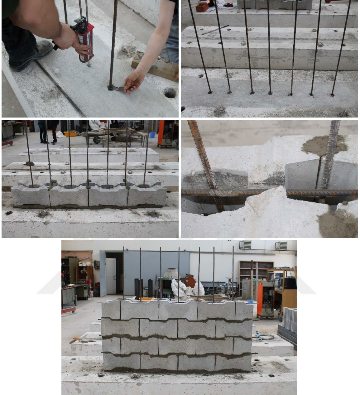
Şekil 2.21. Donatılı yığma duvar inşa aşamaları
