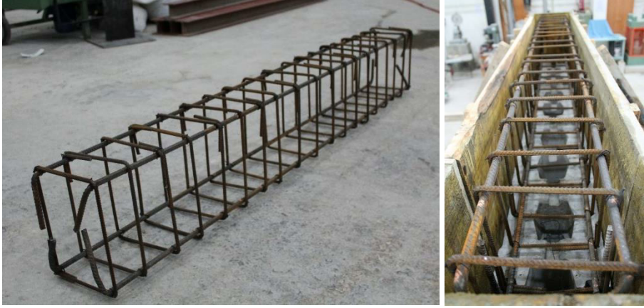
Şekil 2.25. Yatay hatıl donatısı ve kalıplara yerleştirilmesi
