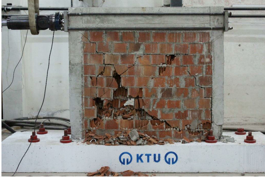
Şekil 3.3. Düzlem içi yükleme deneyi sonunda GYDDE'deki hasar durumu
