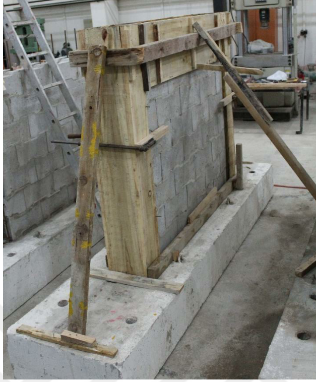
Şekil 2.24. Ahşap kalıp sistemi
