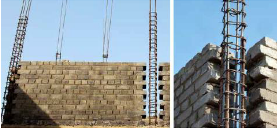
Şekil 1.9. Düşey hatıl uygulamaları [15]
