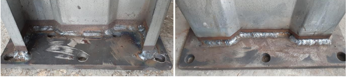
Şekil 31. Profil - başlık levhası kaynak dikişleri
