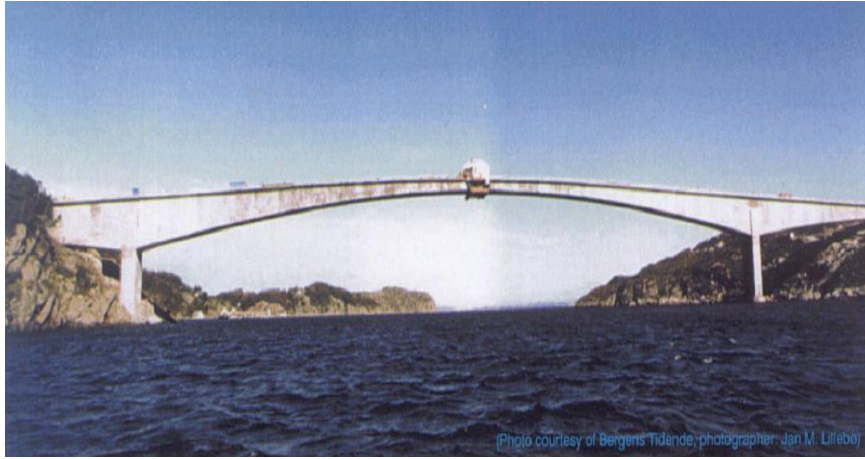
Şekil 2.5. Stolmen Köprüsü, Norveç
