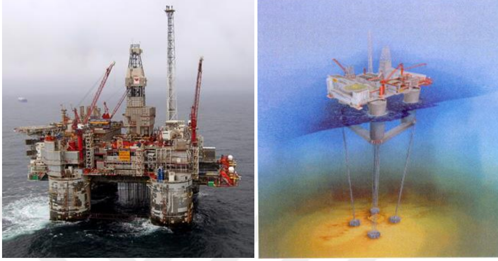
Şekil 2.6. Heidrun Tension Leg Platformu
