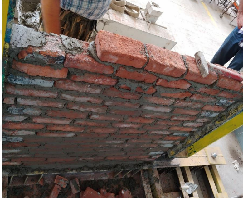
Şekil 2.24. Harman tuğla duvarı yapımı inşaat süreci
