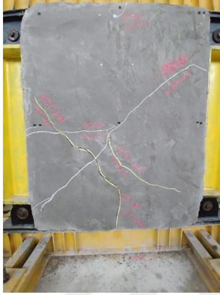
Şekil 2.28. Modal analiz için sensörlerin kurulumuna hazır hasarlı duvar
