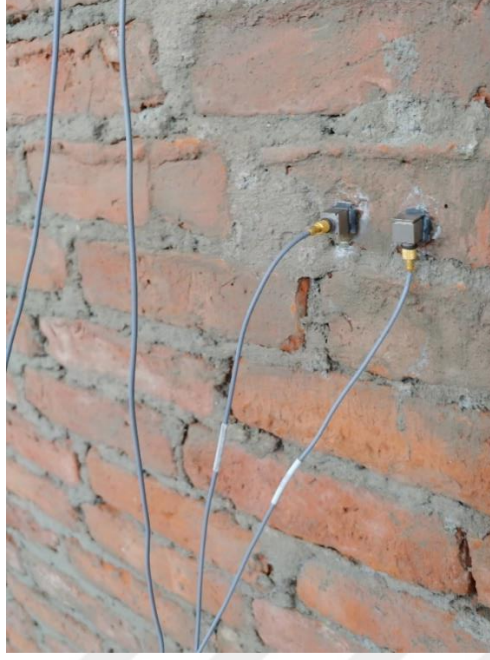
Şekil 2.30. Sensörlerin hasarsız harman duvarına yerleştirilmesi
