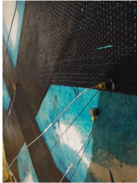
Şekil 2.29. Sensörlerin FRP ile güçlendirilmiş duvarına yerleştirilmesi (üçüncü duvar)
