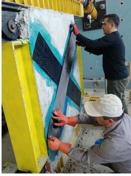
Şekil 2.41. Duvara karbon levhaların uygulanması
