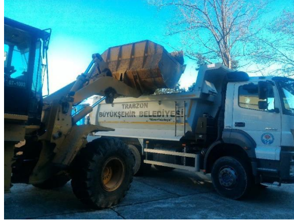
Şekil 2.2. Kırılmış beton plak blokların kamyonlara yüklenmesi
