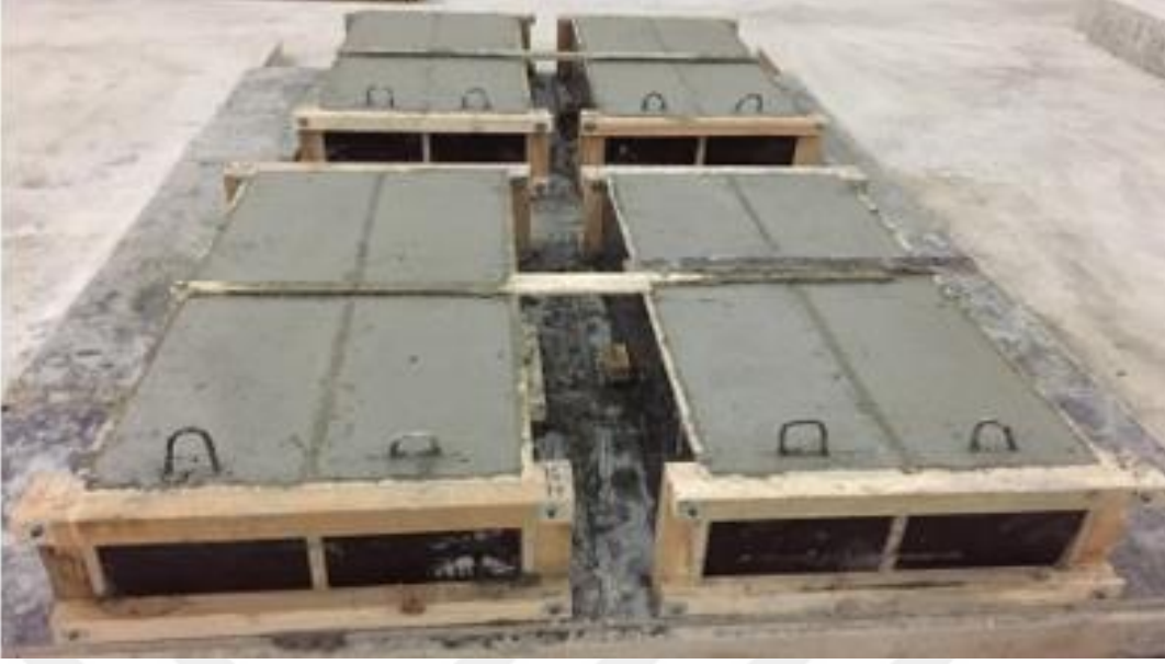
Şekil 2.6. Beton döküm sonrasında bir görünüm
