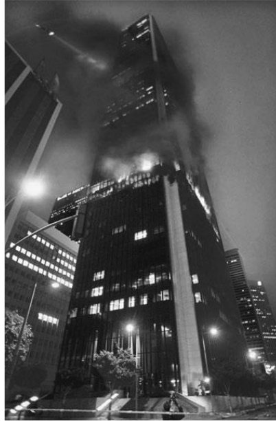
Şekil 1.2. Bir banka binasının 12. katındaki yangın (Buchanan ve Abu, 2017)
