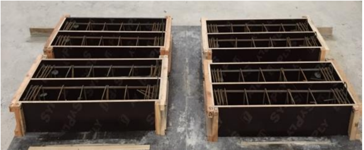
Şekil 2.5. Donatıların kalıp içine yerleştirilmiş hali
