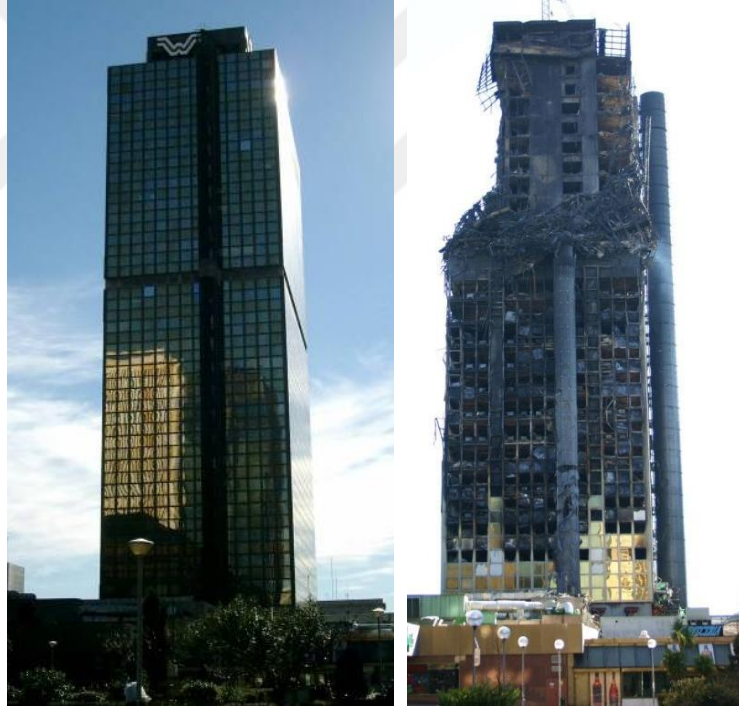
Şekil 1.1. (a) Yangın öncesi ve (b) yangın sonrası Windsor Tower (De Wit, 2011)
