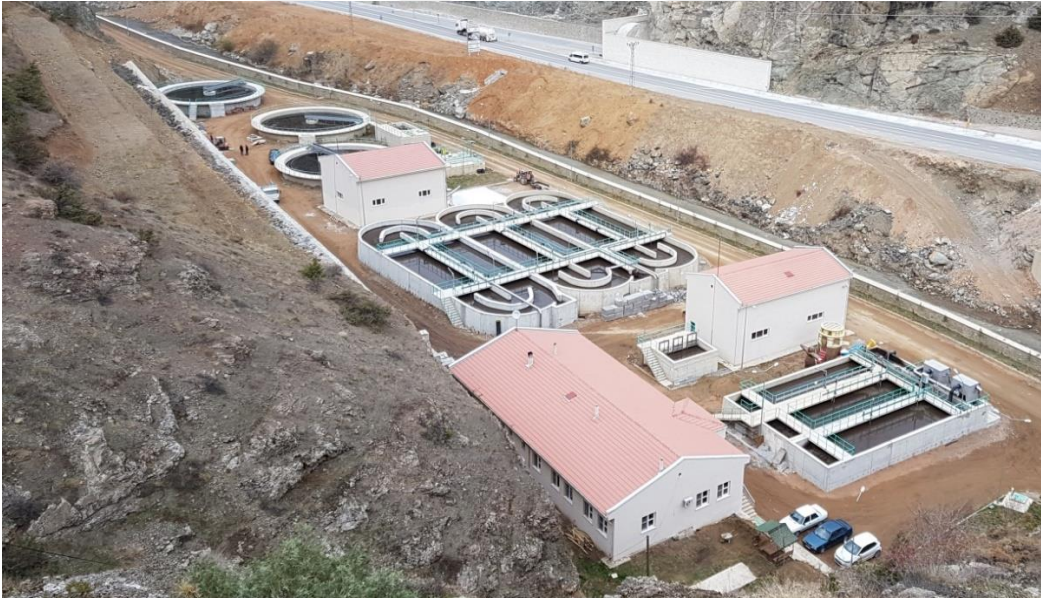
Şekil 2.4. Gümüşhane Atık Su Arıtma Tesisi
