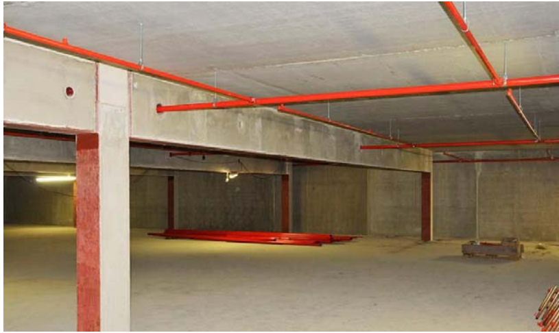
Şekil 1.14. Kısmi gömme kompozit kolonlu yapı (URL-4)
