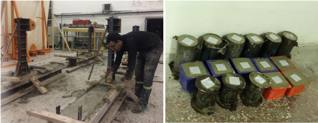
Şekil 2.48. İkinci beton dökümüne ait bazı görüntüler
