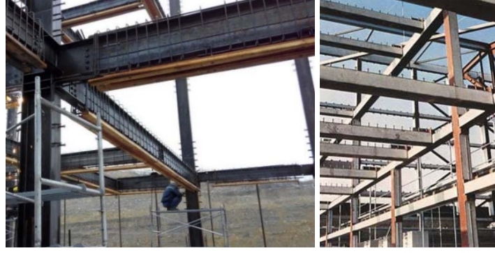
Şekil 1.8. Gömme ve kısmi gömme kompozit kirişe imalatları (URL-2)
