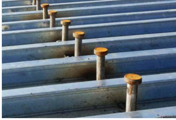
Şekil 1.4. Kayma elemanın uygulama şekli (URL-1)
