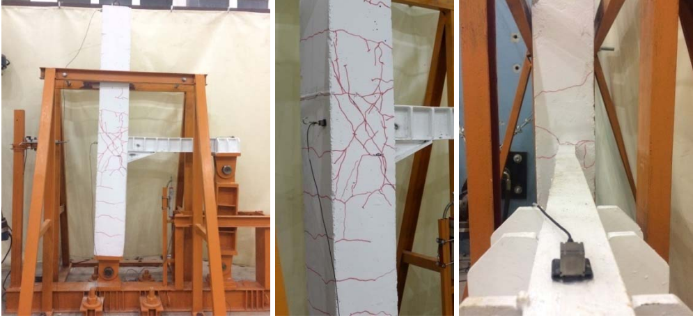
Şekil 3.132. Hasarlı KKB-F elemanın çevresel titreşim testinden bazı görünümüler
