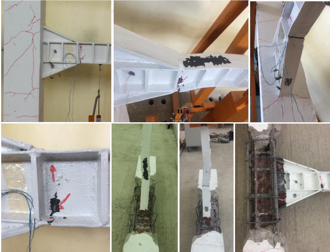
Şekil 3.21. Deney sonunda KKB-E deney elemanında oluşan hasar durumları
