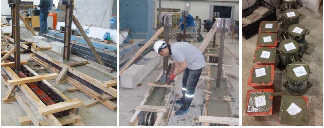
Şekil 2.46. Birinci beton dökümüne ait görüntüler
