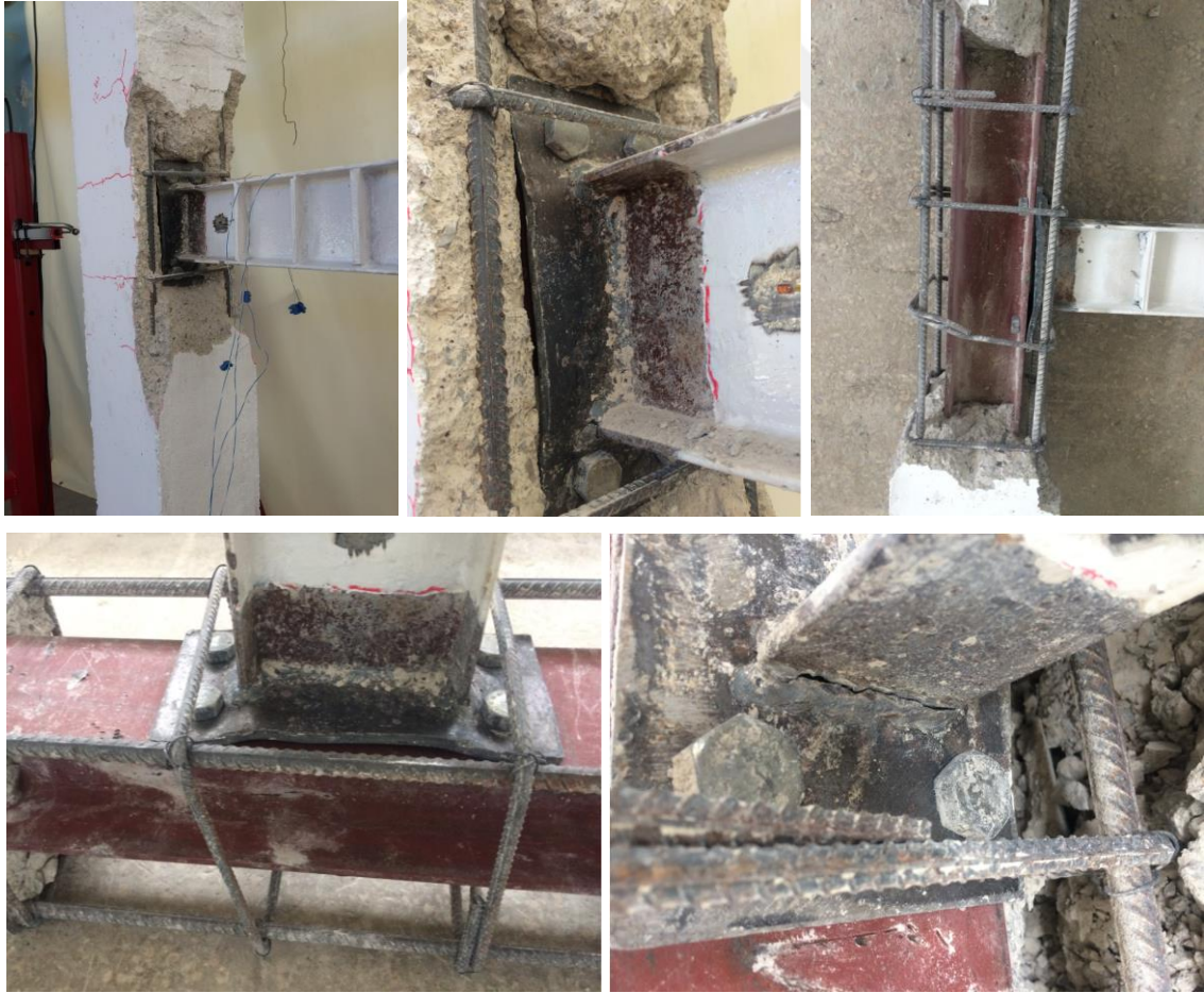
Şekil 3.5. Deney sonunda KKB-A deney elemanında oluşan hasar durumları
