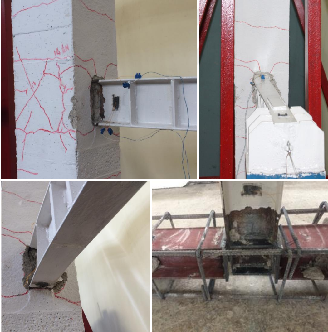
Şekil 3.9. Deney sonunda KKB-B deney elemanında oluşan hasar durumları
