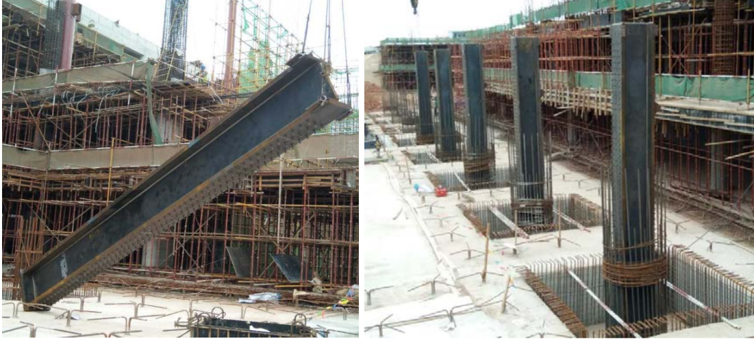
Şekil 1.11. Gömme kompozit kolon imalat detayı (URL-3)
