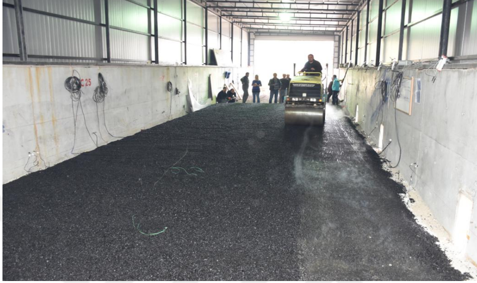
Şekil 2.38. Asfalt kaplamanın sıkıştırılması
