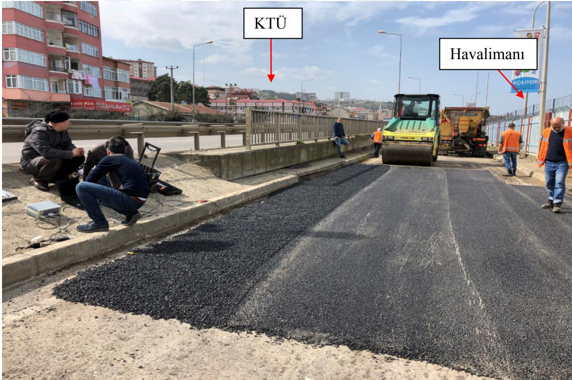
Şekil 2.13. Arazide silindirle sıkıştırma işleminin yapılması
