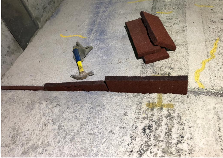
Şekil 2.23. Derze yerleştirilen kauçuk karolar
