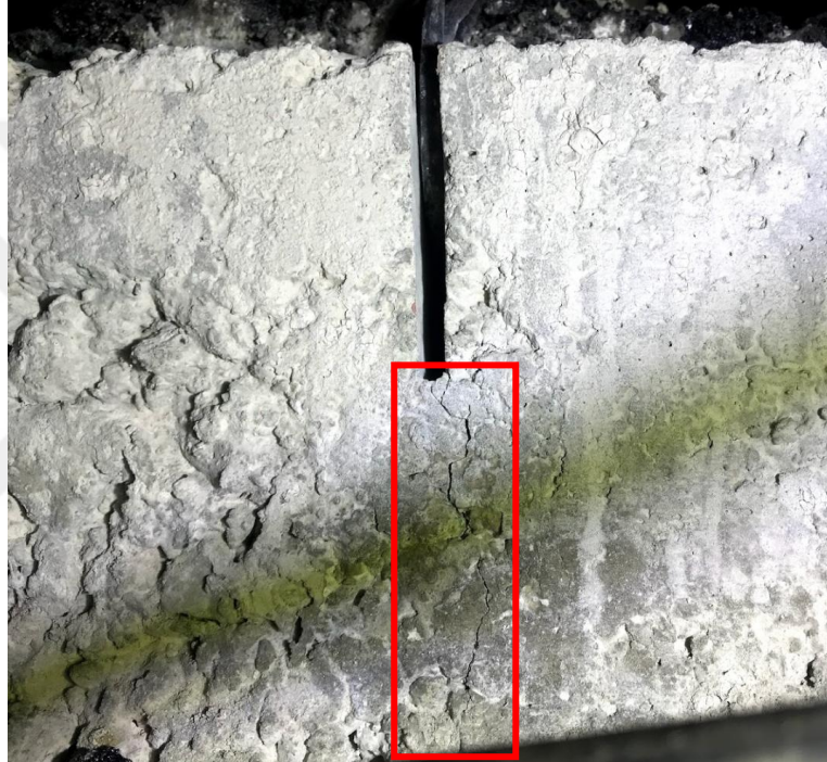
Şekil 1.6. Büzülme derzi ve istenilen çatlak
