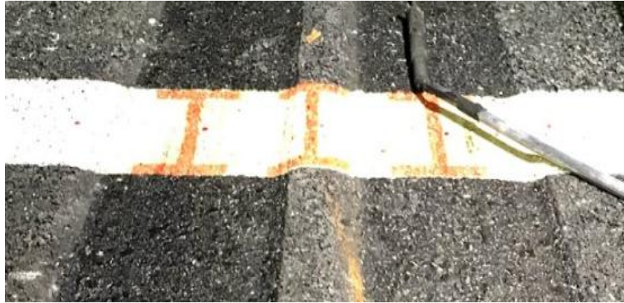
Şekil 3.32. Batı şeridi 1. derz bölgesinde tekerlek izi oluşumunun gösterimi
