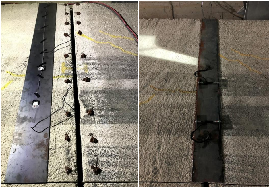
Şekil 2.27. Çelik levhaların derz bölgesine yapıştırılması
