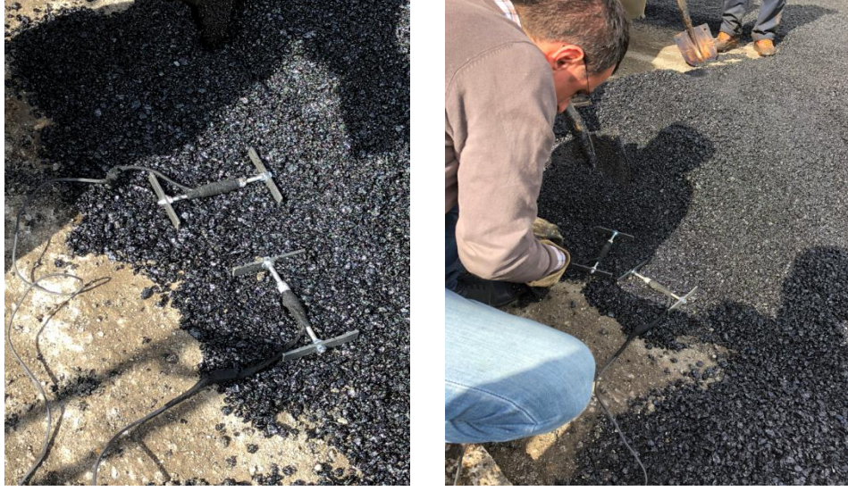
Şekil 3.7. Arazide BŞD ölçerlerin yerleştirilmesi
