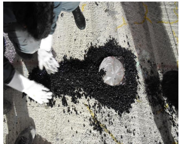
Şekil 2.35. BŞD ölçerlerin ve basınç ölçerlerin tabanının asfalt kaplama ile desteklenilmesi
