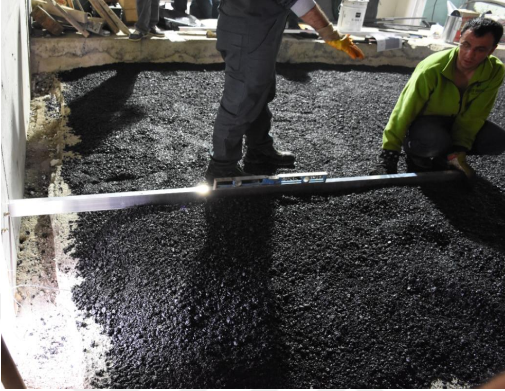
Şekil 2.36. Asfalt kaplama yüzeyinin teraziye alınması
