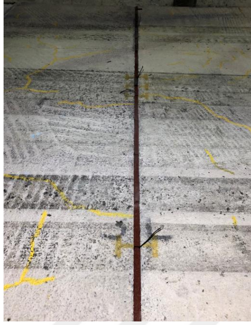
Şekil 2.24. Derze yerleştirilen kauçuk karoların yerleşmiş görünümü
