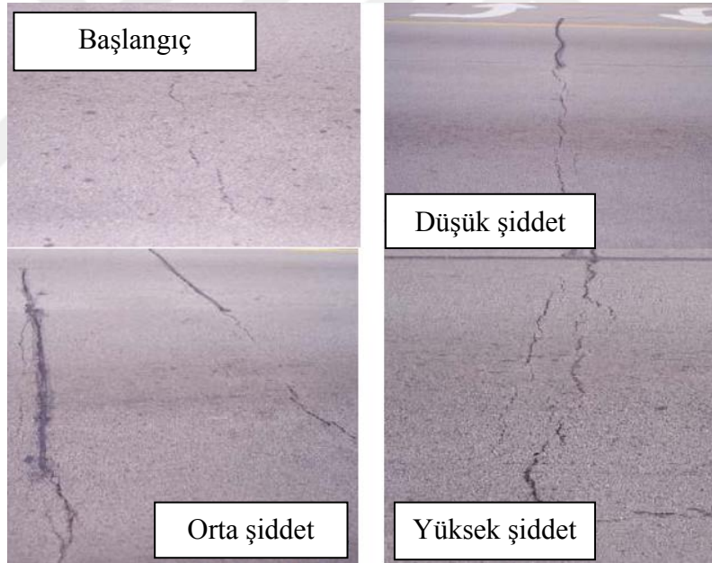
Şekil 1.13. Farklı şiddet düzeylerindeki yansıma çatlakları (Al-Qadi vd., 2008).
