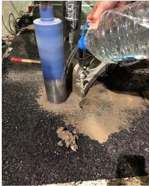
Şekil 3.39. Asfalt kaplamalardan karot alınması
