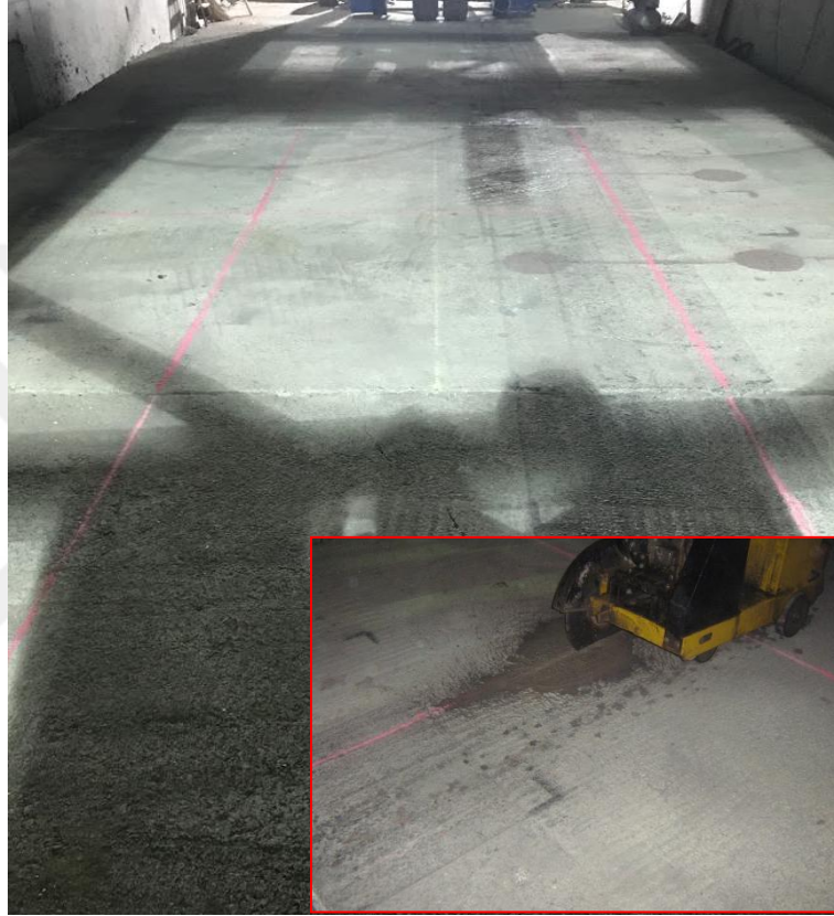
Şekil 2.17. Beton kaplamaların boyuna yönde şeritlere ayrılması
