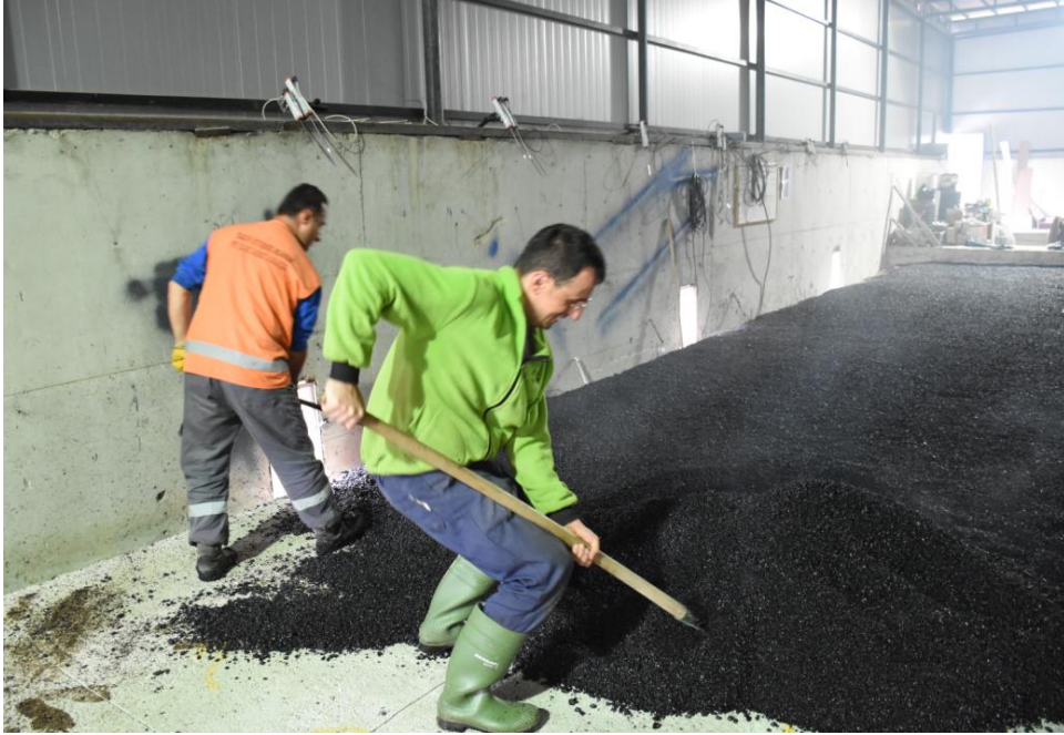
Şekil 2.37. Asfalt kaplamanın serilmesi
