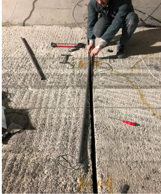
Şekil 2.30. BŞD ölçer kablolarının derz içine yerleştirilmesi
