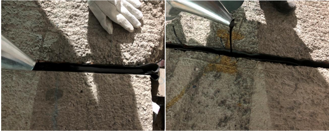
Şekil 2.22. Derze yerleştirilen kauçuk EPDM ve Is-seal (RJF) malzemesi
