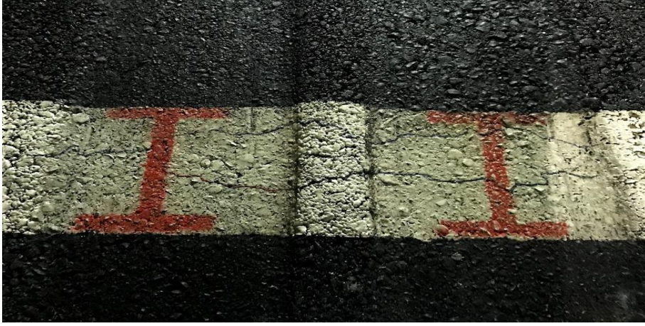
Şekil 3.33. Batı şeridi 2. derz bölgesinde tekerlek izi oluşumunun gösterimi
