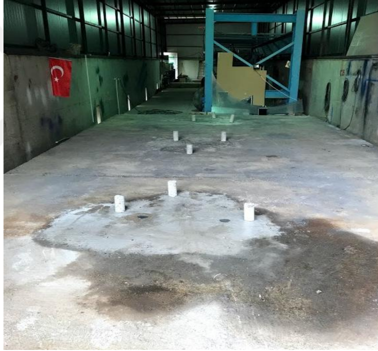
Şekil 2.16. Beton yoldan karot numunelerin alınması
