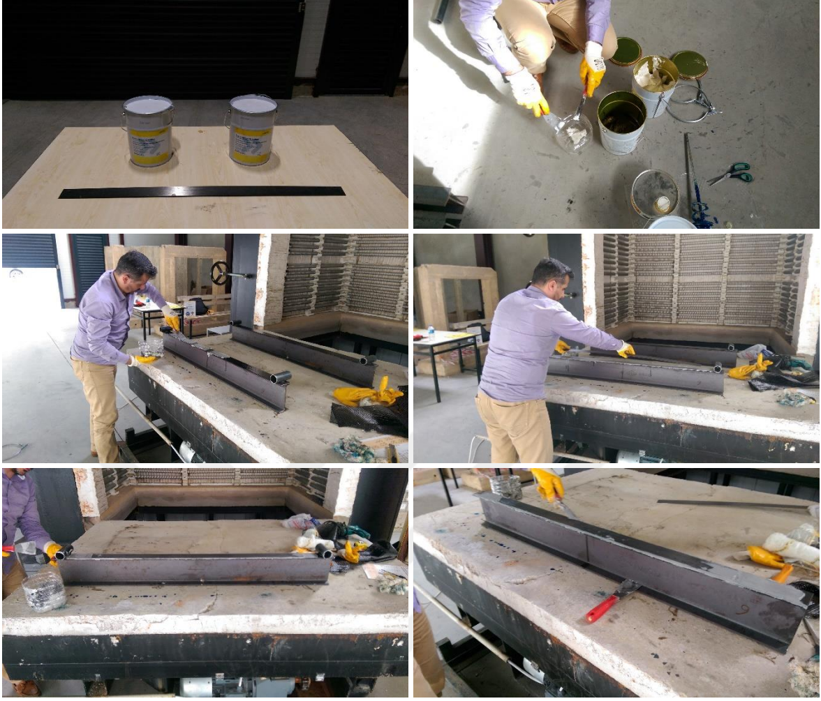
Şekil 2.97. KFTP plaka ile yapılan güçlendirme uygulaması
