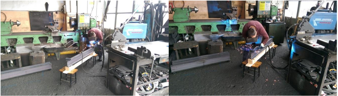
Şekil 2.53. Dairesel mesnetlerin numuneler üzerine köşe kaynak işlemi ile birleştirilme aşaması
