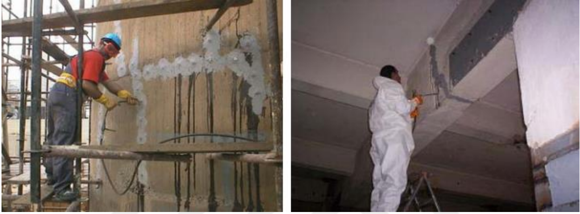
Şekil 1.66. MasterInject 1302 ile betonarme yapılardaki çatlak onarım örnekleri
