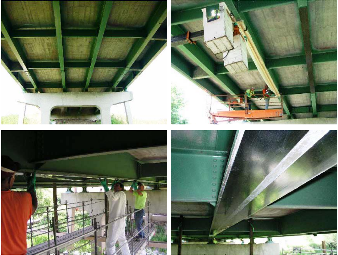
Şekil 1.64. Kompozit bir köprünün çelik kirişlerinin KFTP malzemesi ile güçlendirilmesi (Taljsten vd., 2007).
