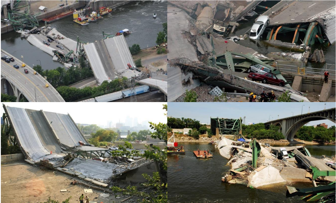
Şekil 1.60. I-35W Köprüsü'nde meydana gelen hasara ait görseller (URL-14, 2018).
