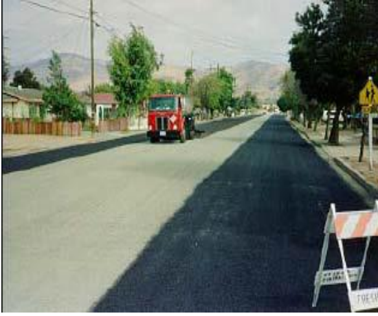
Şekil 7. Karartma tabakası uygulaması [25] Şekil 8. Uygun yüzey [25]
