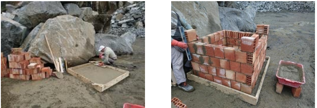
Şekil 2.1. Deneysel çalışmaya ait tuğla duvar yapım aşamaları
