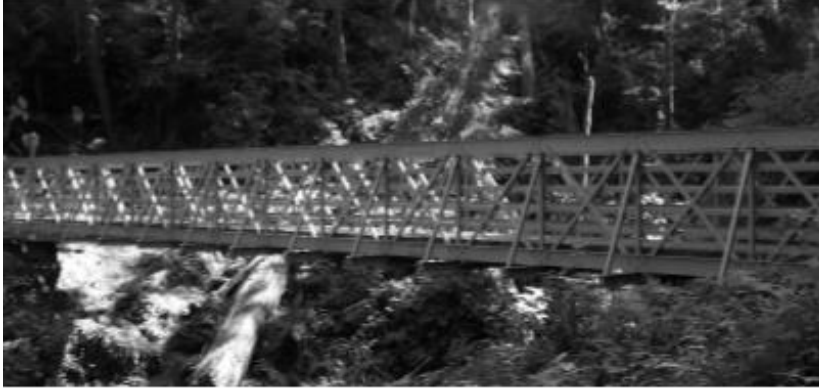
Şekil 1.13. Pultrüzyon LP malzemeli yaya köprüsü (ET Techtonics.) (Akıncı, 2010)
