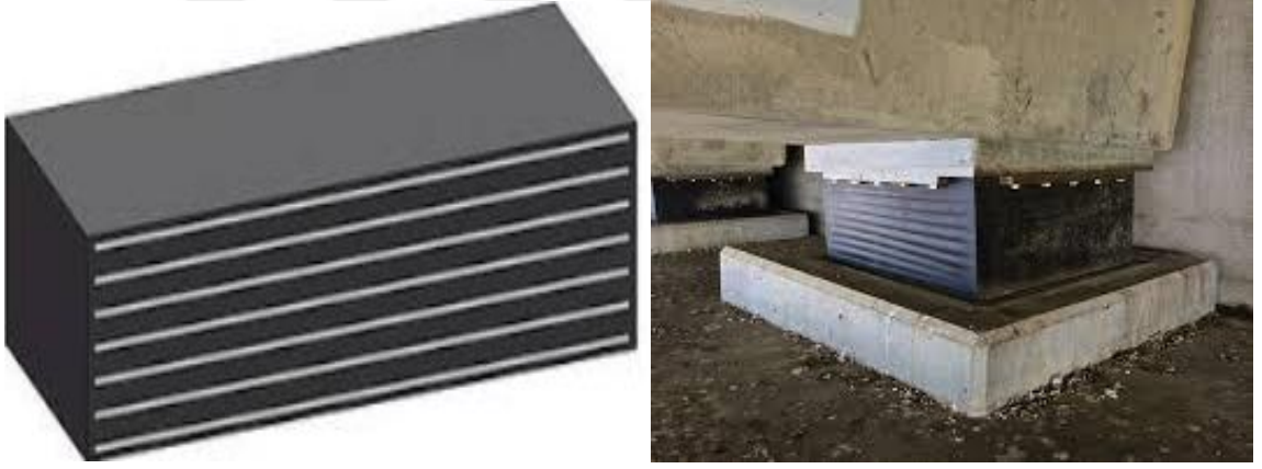
Şekil 1.18. Elastomer mesnet yastığı ve mesnetlerin üst ve alt yapıyla bağlantısı (URL-(4-5), 2018)
