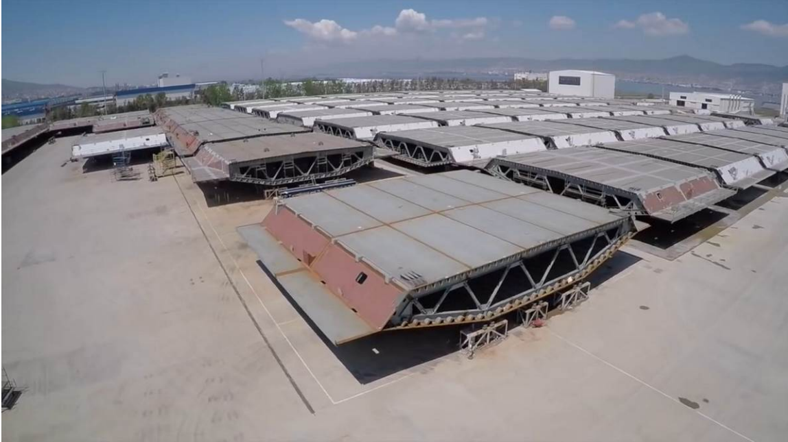
Şekil 2.6. Osmangazi Köprüsü'nün tabliye yapım aşamalarına ait bazı fotoğraflar (URL-24, 2019).
