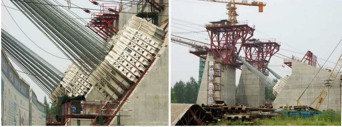
Şekil 1.20. Ana kabloların gerilmesi (URL-14, 2019).
