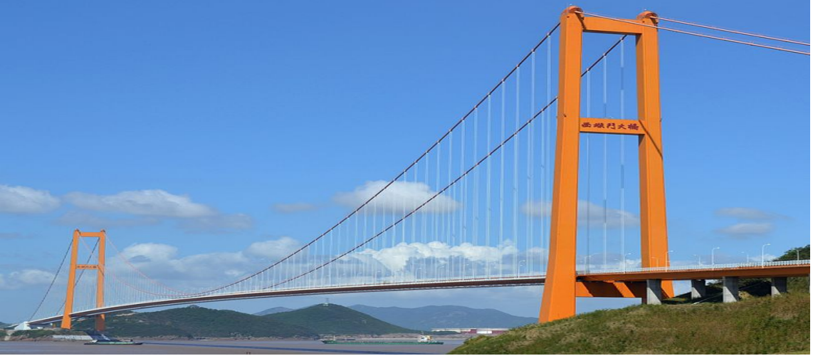
Şekil 1.16. Xihoumen Köprüsü (URL-9, 2019).
