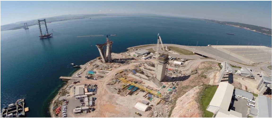
Şekil 2.9. Osmangazi Köprüsü'nün ankraj bloklarının yapım aşamalarına ait bazı fotoğraflar (URL-24, 2019).
