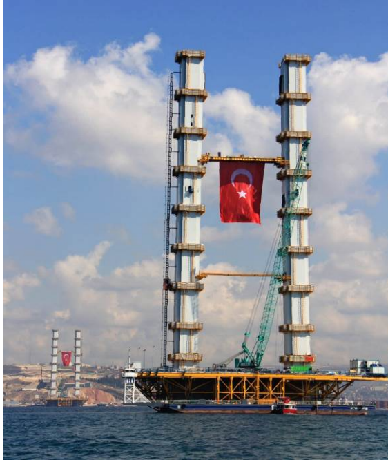
Şekil 2.4. Osmangazi Köprüsü'nün kule yapım aşamalarına ait bazı fotoğraflar (URL-24, 2019).
