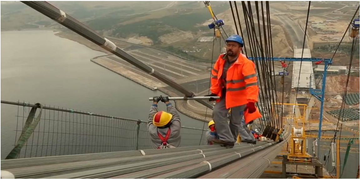
Şekil 2.5. Osmangazi Köprüsü'nün ana kablo yapım aşamalarına ait bazı fotoğraflar (URL-24, 2019).
