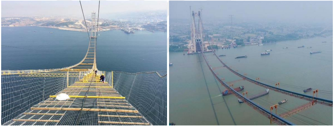
Şekil 1.19. İskele sistemi inşası (URL-13, 2019).
