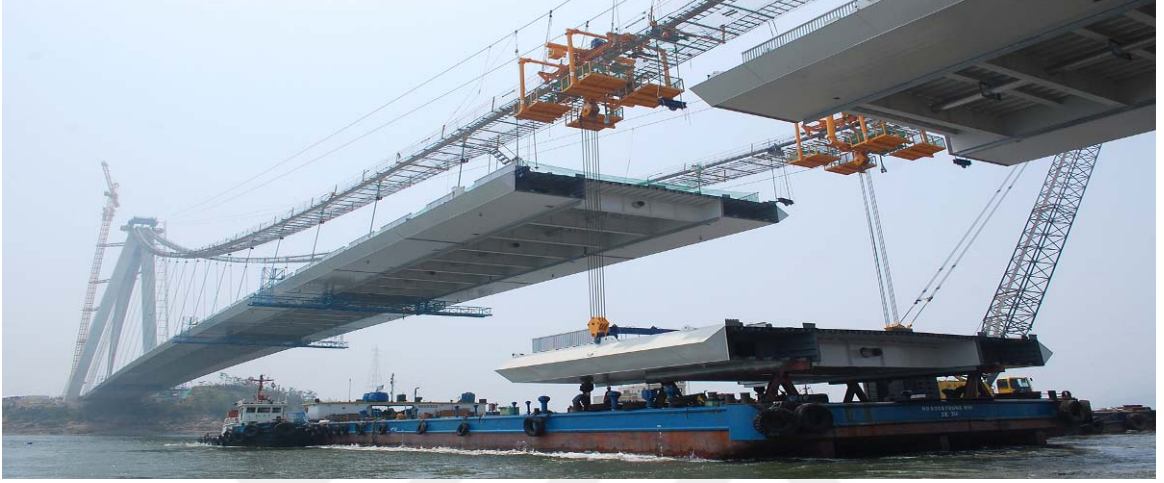
Şekil 1.21. Tabliye segmentinin yerine yerleştirilmesi (URL-15, 2019).
