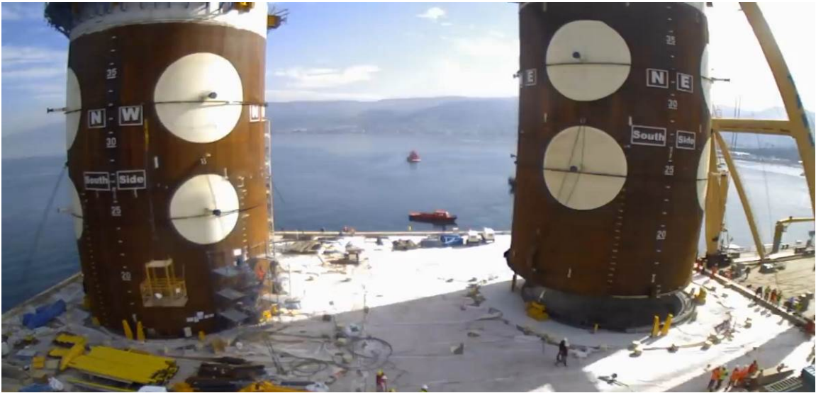
Şekil 2.11. Osmangazi Köprüsü'nün kule temellerinin yapım aşamalarına ait bazı fotoğraflar (URL-24, 2019).
