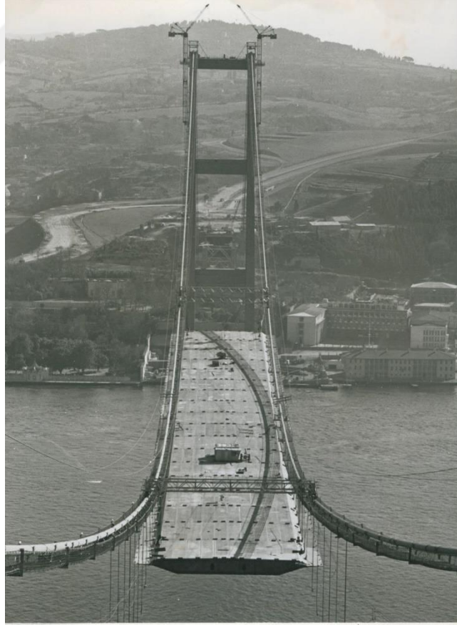
Şekil 2.8. Tabliye montajı [45]
