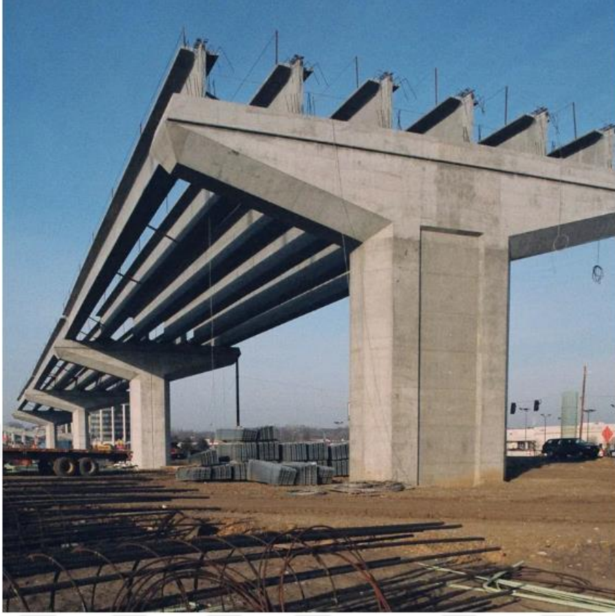
Şekil 1.7. Öngerilimli Beton Köprüler
