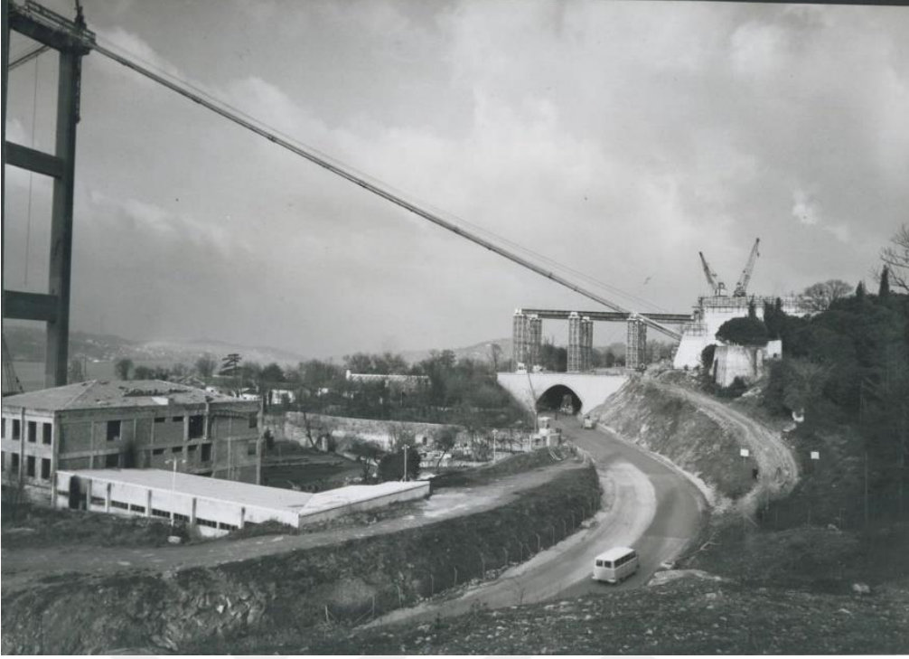
Şekil 2.9. Ortaköy Yaklaşım Viyadüğü montajı [45]
