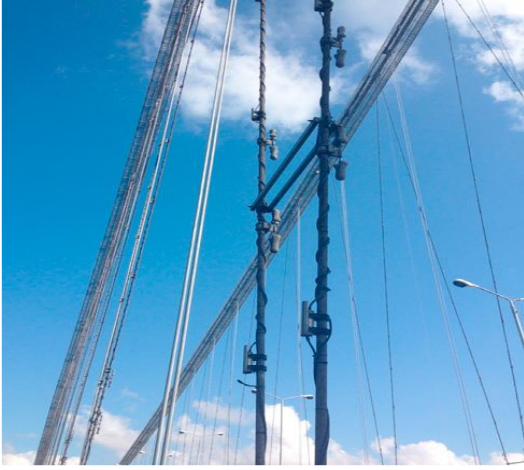
Şekil 2.2. Boğaziçi Köprüsü askılarının değişim süreci [17]
