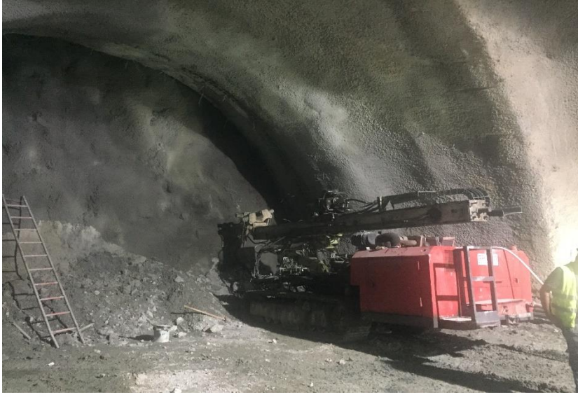
Şekil 20. Şemsiye Kemer Yöntemi Zemin Delgi Makinesi
