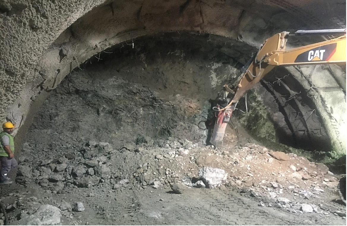
Ek 38. Tünel Göçük Bölgesi Kazı Çalışması
