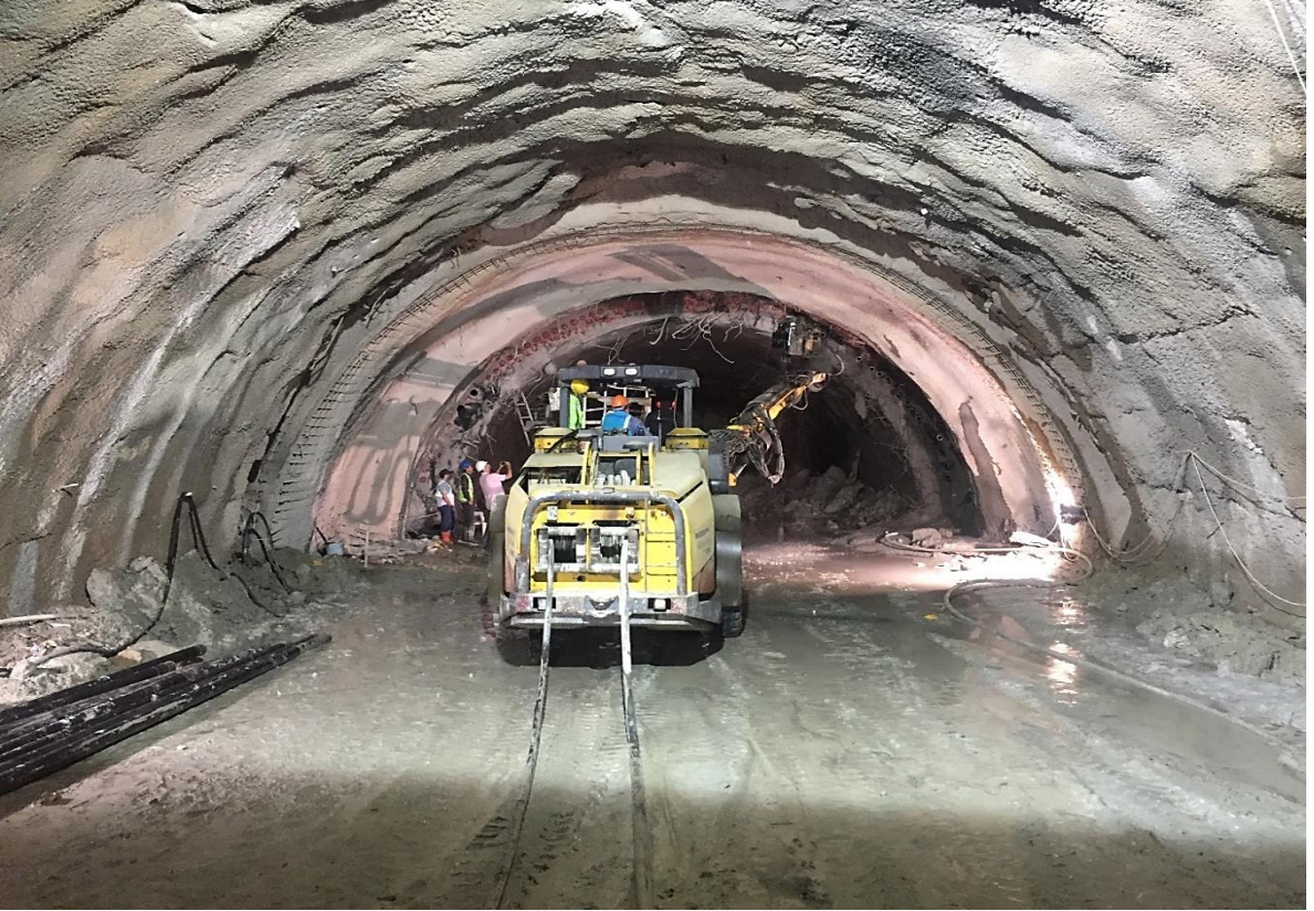
Ek 44. Tünel Göçük Bölgesi Şemsiye Kemer Delgisi Yapılırken
