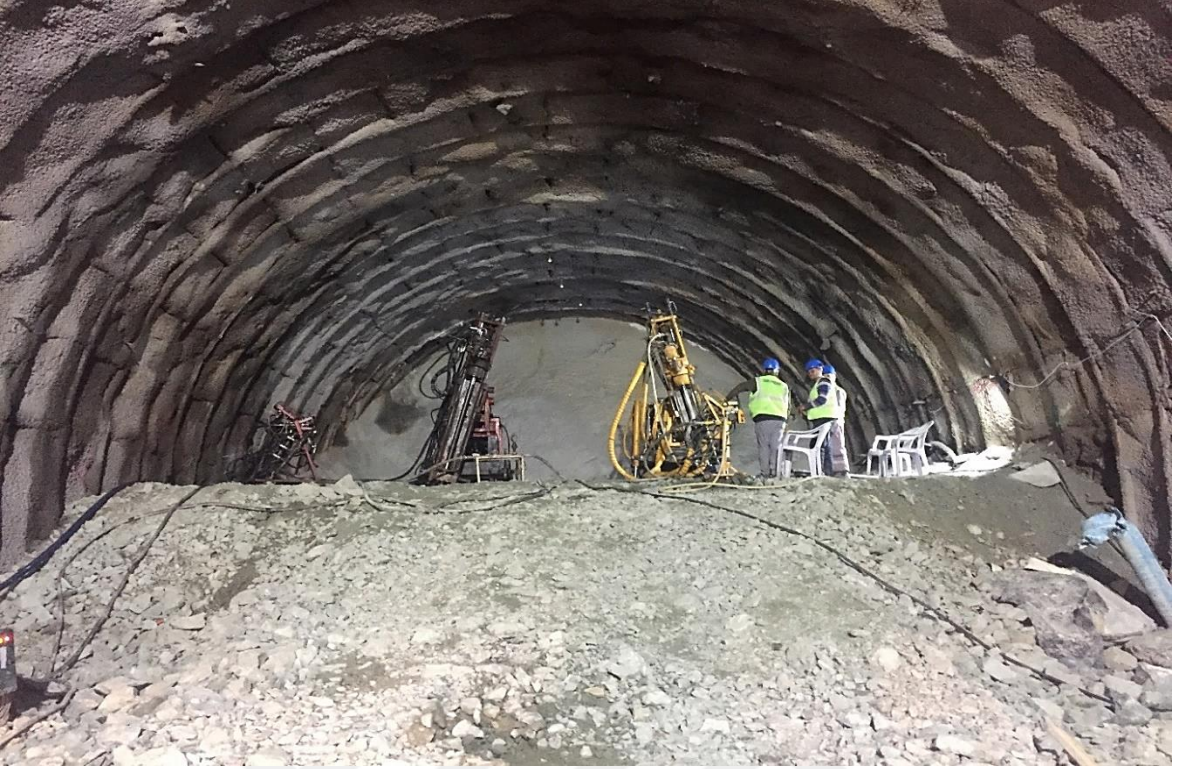
Ek 39. Tünel Göçük Bölgesi Enjeksiyon Yapılması
