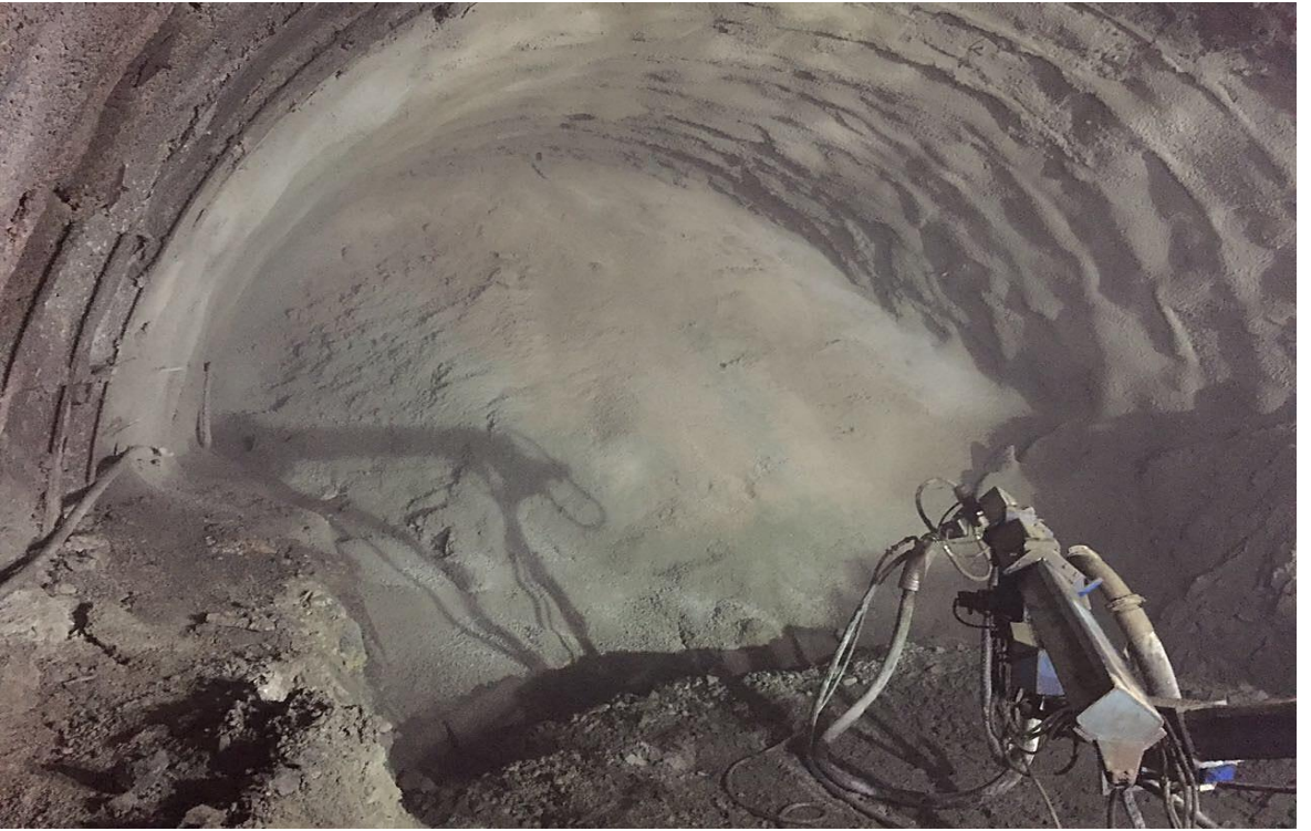
Ek 36. Tünel Göçük Bölgesi Püskürtme Beton Atılması
