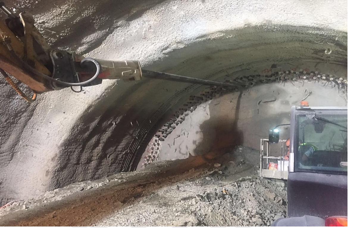
Ek 41. Tünel Göçük Bölgesi Şemsiye Kemer Borusu Sürerken
