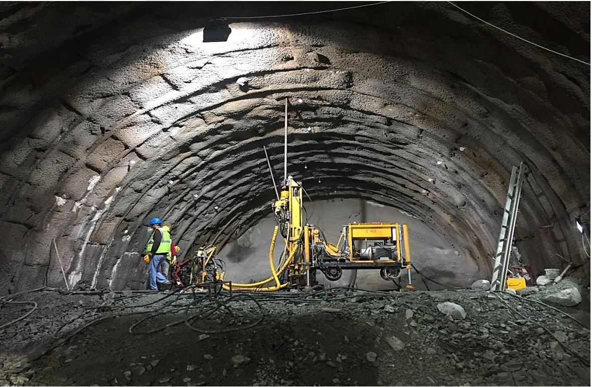
Ek 40. Tünel Göçük Bölgesi Enjeksiyon Delgisi Yapılırken
