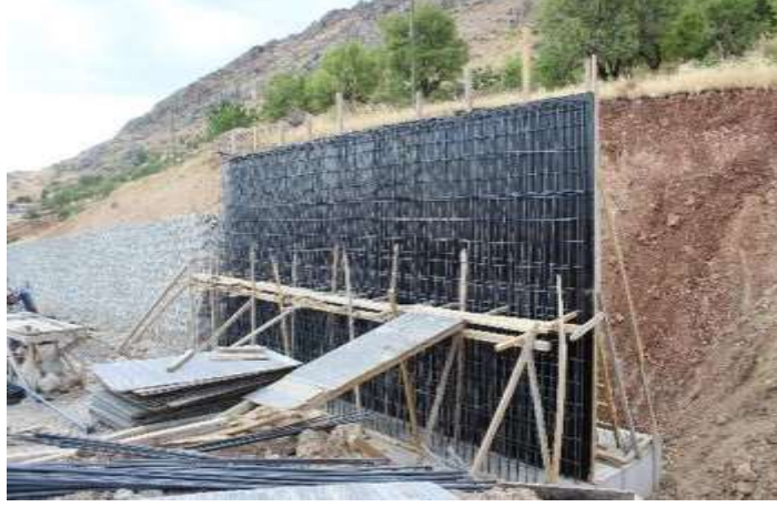
Şekil 1.31. Betonarme duvar görünümü
