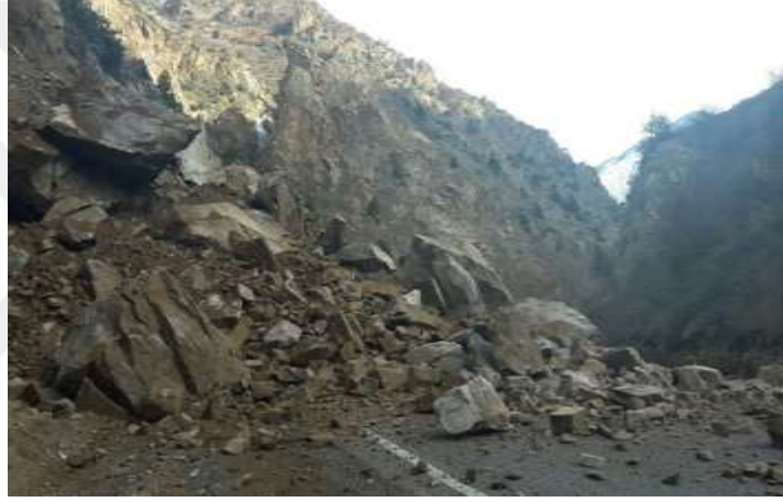
Őekil 1.4. Artvin-Ardahan karayolunda meydana gelen heyelan
