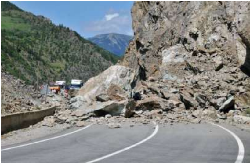
Şekil 1.9. Tirebolu - Torul yolunda devrilme türü hareket
