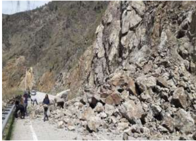
Şekil 1.7. Gümüşhane-Tirebolu yolunda düşme tipi zemin hareketi
