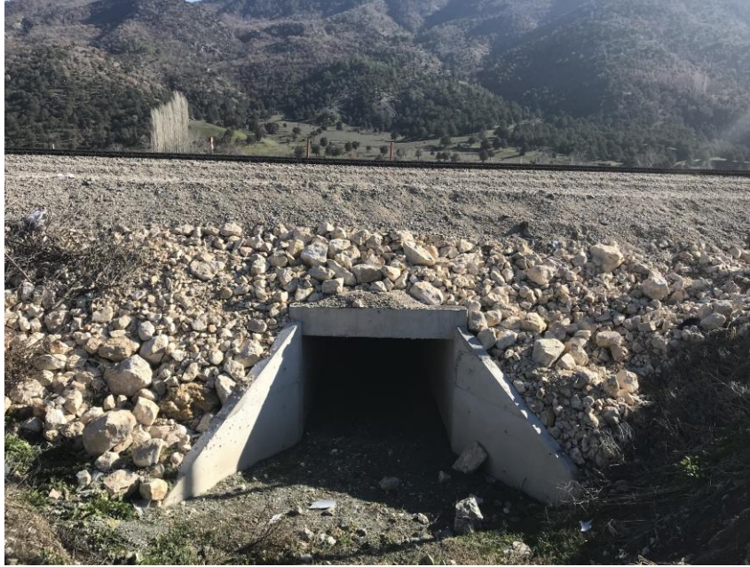
Şekil 1. Amasya-Turhal yolu üzerinde yapılan kutu kesitli betonarme menfez
