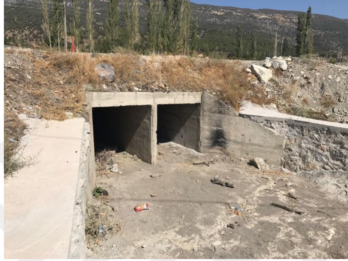
Şekil 4. Kutu kesitli betonarme menfez örneği, Amasya-Turhal karayolu
