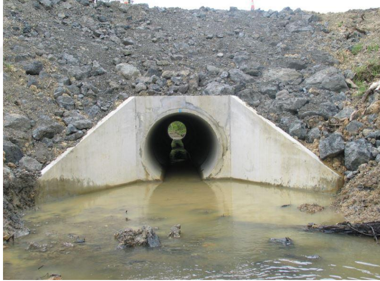
Şekil 3. Boru kesitli betonarme menfez örneği (URL-4, 2019)
