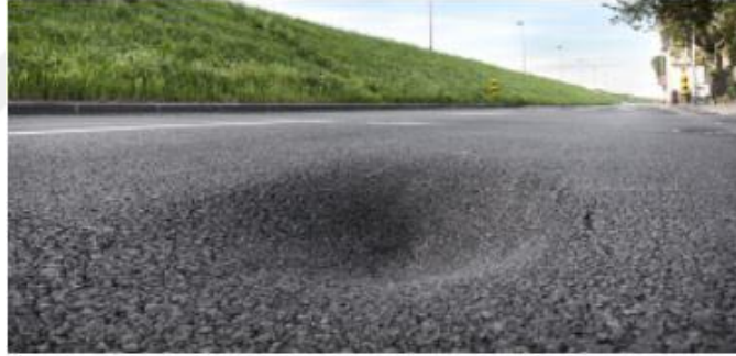
Şekil 10. Kaplamada oturma (URL-6, 2019)
