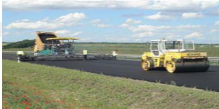
Şekil 3. BSK serilip sıkıştırılması çalışması (URL-2, 2019)
