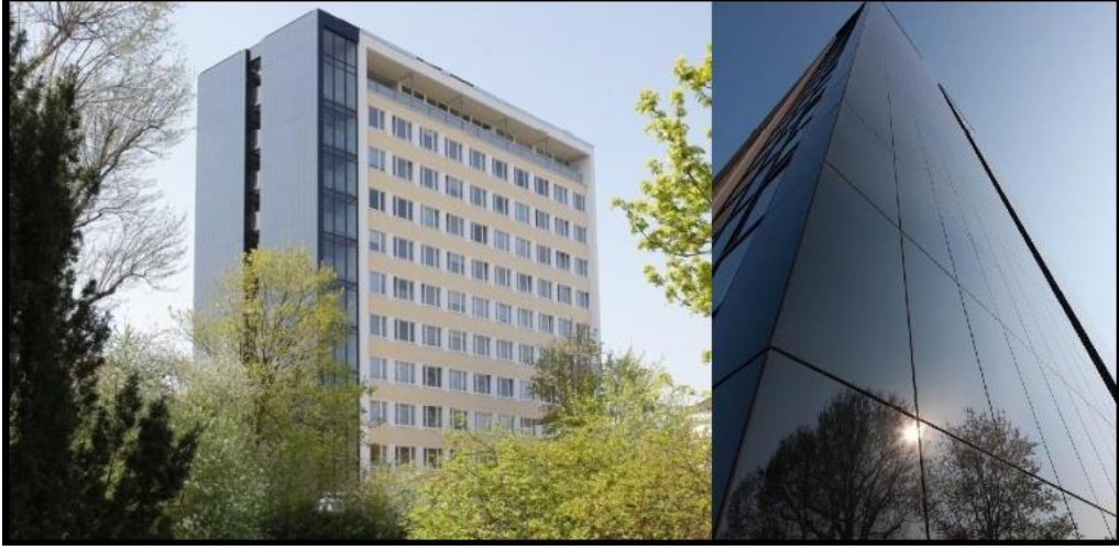
Şekil 1.18. Erfurt üniversitesi ek binası cephe entegre pv panel görüntüsü (URL-7, 2019)
