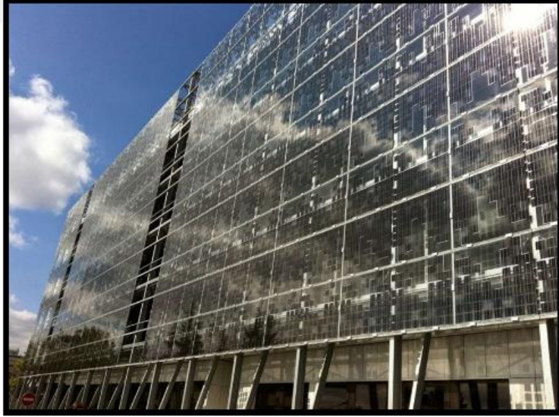
Şekil 1.19. Engie binası pv panel kaplaması (Süzer, 2019)
