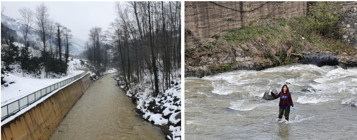
Şekil 27. G02 istasyonu memba (12.02.2020) ve mansap (27.03.2020) görünümü
