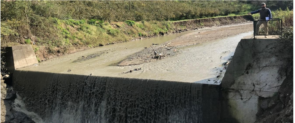
Şekil 2. Sera Deresi (Trabzon) ana kol üzerinde membadaki dördüncü tersip bendi (03.11.2018)
