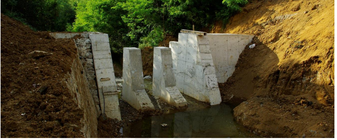
Şekil 4. Sera Deresi (Trabzon) Hocarat yan kolu üzerinde inşa edilen geçirimli tersip bendi (20.08.2020)
