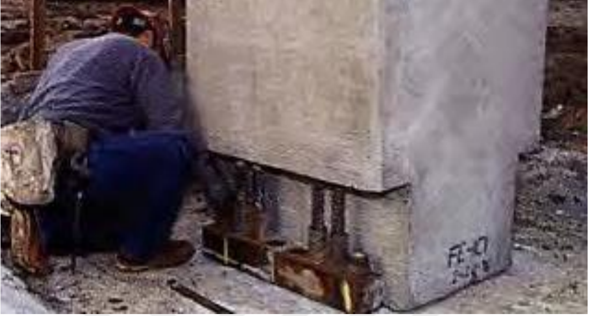
Şekil 9. Englekirk (1996) tarafından sunulan prekast birleşim
