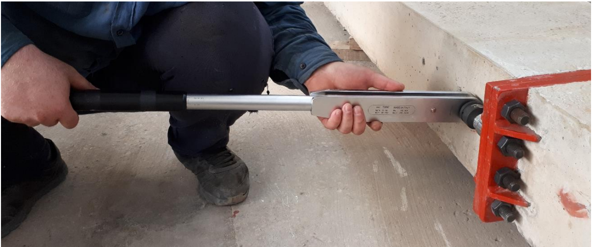
Şekil 75. Kiriş – kiriş numuneleri birleştirilme esnasında cıvataların torklanması (sıkılması) işlemi
