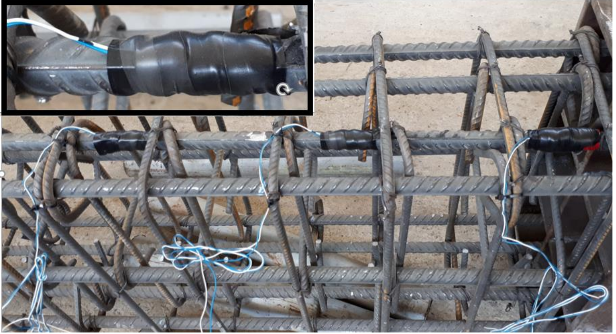
Şekil 56. Donatı üzerine birim şekil deęiřtirme ölçerlerin (strain-gauge) yapıştırılması
