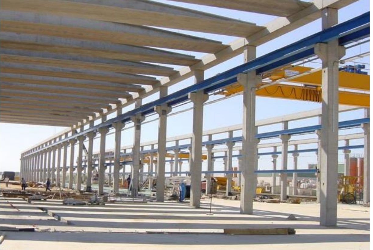
Şekil 2. Sanayi tipi bir prekast yapı örneği
