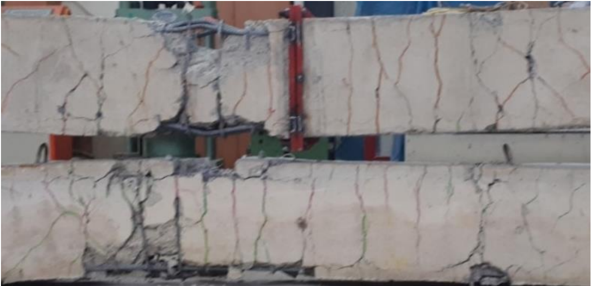
Şekil 164. Açıklığı 4.0 m olan kiriş – kiriş birleşim numuneleri deney sonrası yakın görünüşleri
