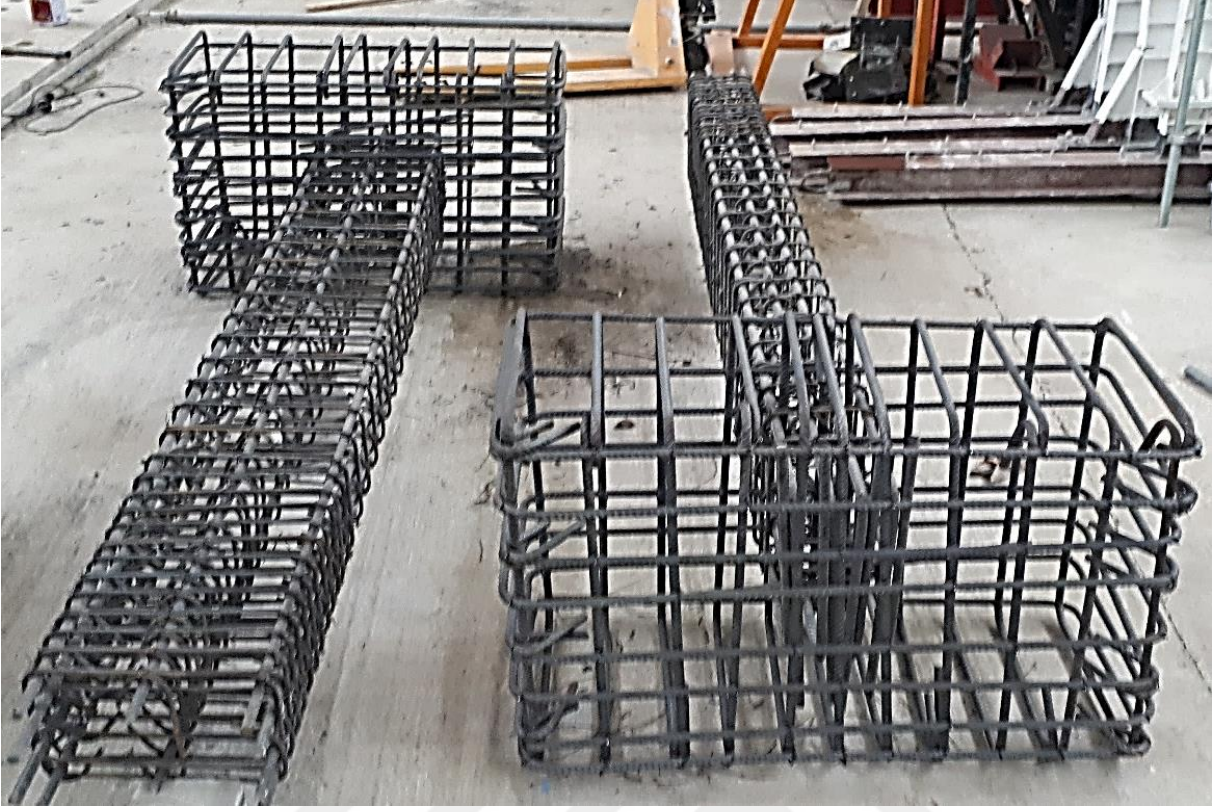
Şekil 46. Temel – kolon birleşimi deney numunesi donatı iskeleti (monolitik numuneler)
