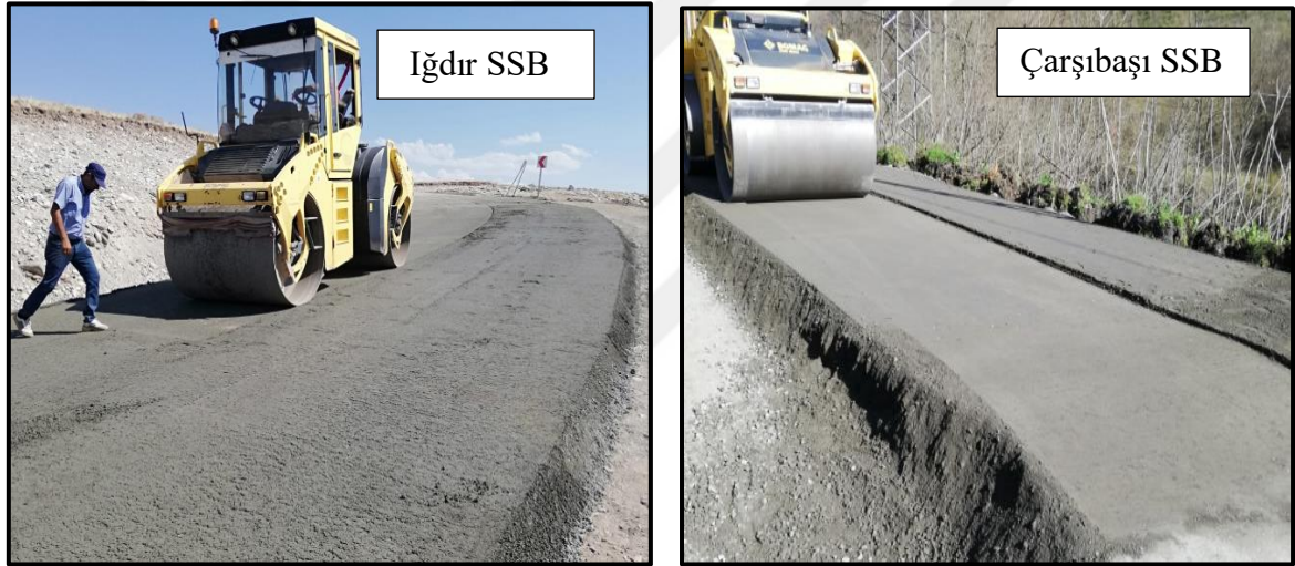
Şekil 1.5. Silindirle sıkıştırılmış beton yol görünüşleri [17].
