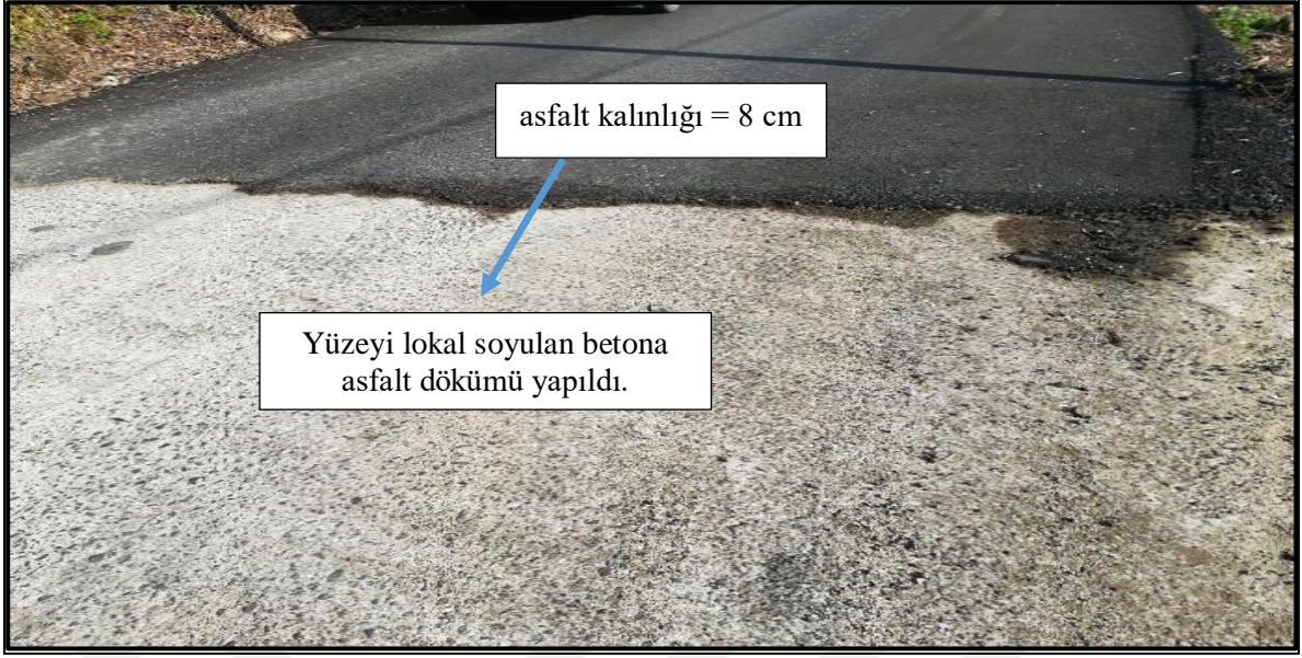
Şekil 1.21. 15 yıl önceki beton yola asfalt serimi uygulanmıştır.(Kirazlık mah./ Vakfikebir)
