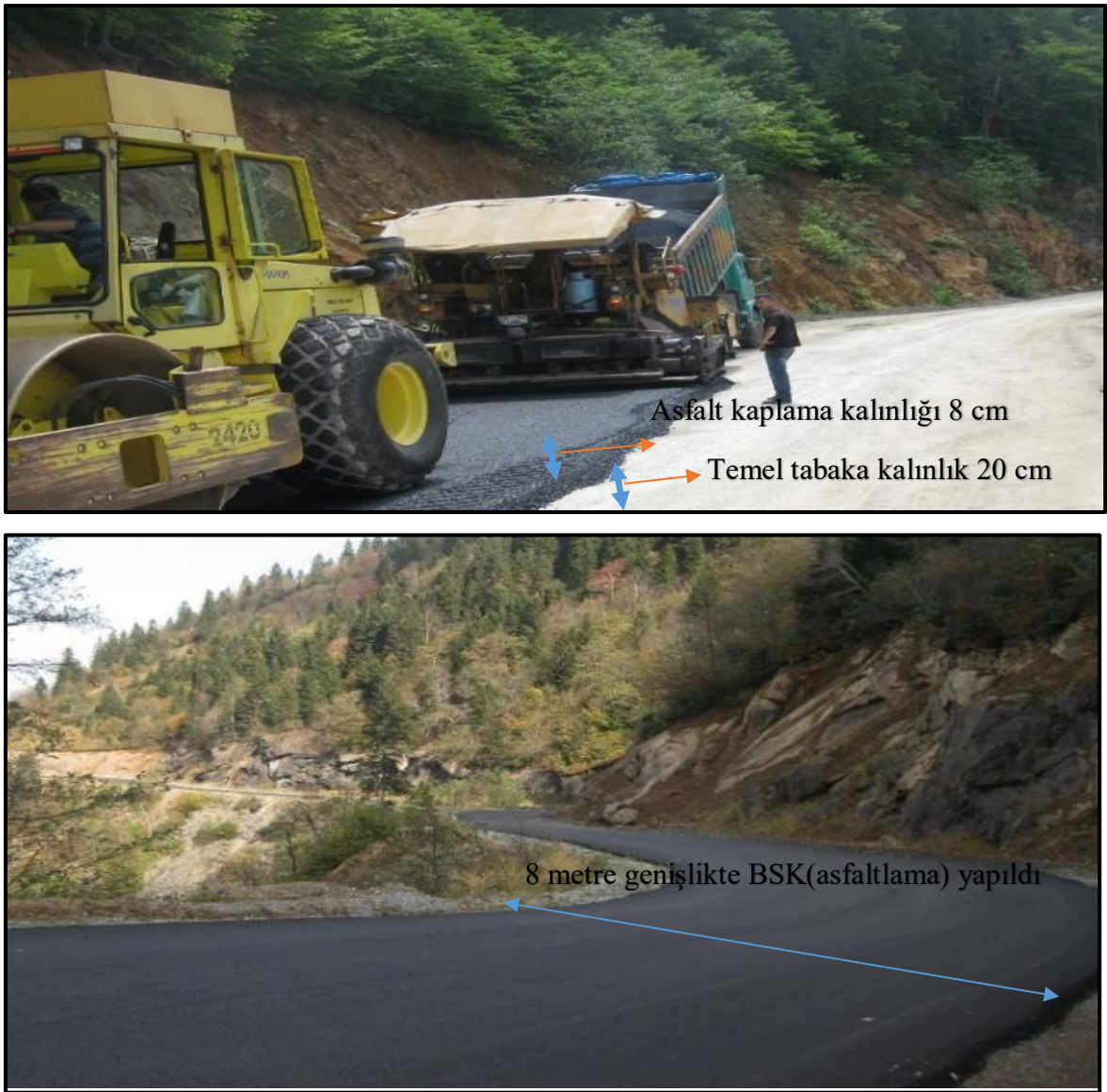
Şekil.2.38. Sultanmurat Yaylası - Dernekpazarı yolu üzeri asfalt yol yapımı (2014 yılı)
