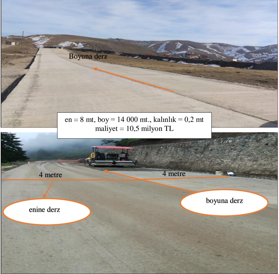
Şekil 1.22. Erikbeli-Kadırga yolu arasında beton yol finişerleri ile yapılan yoldan görünümler
