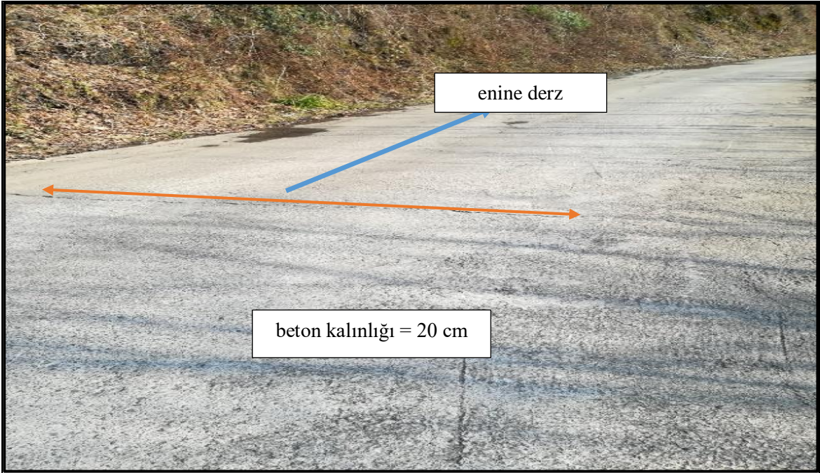
Şekil 1.20. 15 yıl önceki beton yola asfalt serimi uygulanmıştır.(Kirazlık mah./ Vakfikebir)
