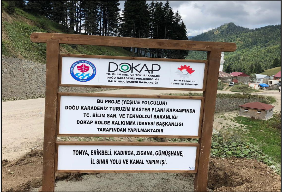
Şekil 2.29. Erikbeli Yaylası beton yol inşaatı işinin başlangıç noktası tabelası
