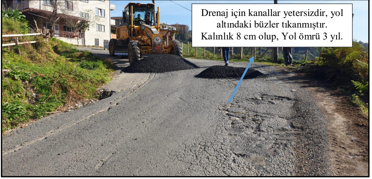
Şekil 1.17. Bozulan bir asfalt yola greyderle bakım-onarım yapılırken
