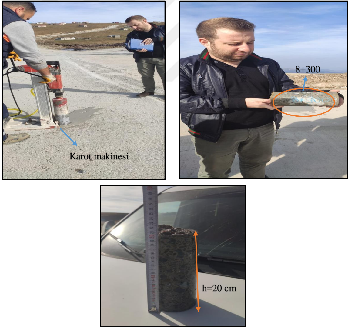
Şekil 2.32. Erikbeli – Kadırğa yolu 8+300 km den karot numunesi görünümleri
