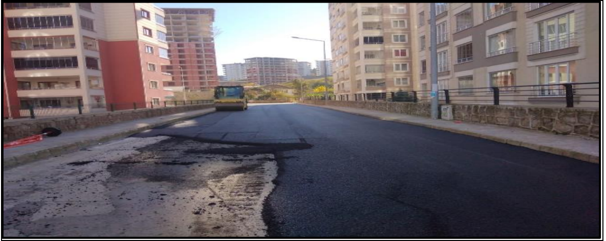
Şekil 1.18. Yüzeyi bozulan asfaltın üzerine 8 cm asfalt serilmesi (Çukurçayır Mah.Trabzon)
