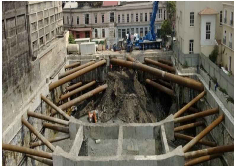
Şekil 1.21. Gergi (çelik borulu destek) örneği.
