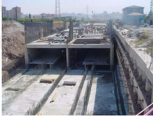
Şekil 1.7. Aç-kapa kazı yöntemi görünümü
