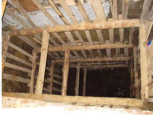
Şekil 1.8. Kuyu tipi duvar yöntemi görünümü
