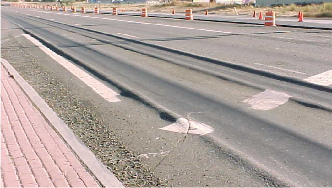
Şekil 5. Tekerlek izi (İncegöl, 2010).
