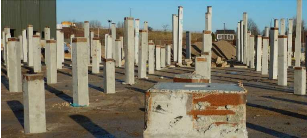
Şekil 1.35. Önceden dökme betonarme kazıklar örneği
