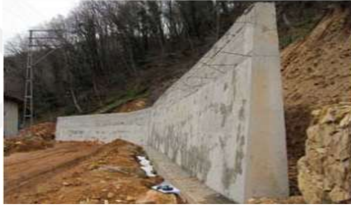
Őekil 1.32. Betonarme istinat duvarı
