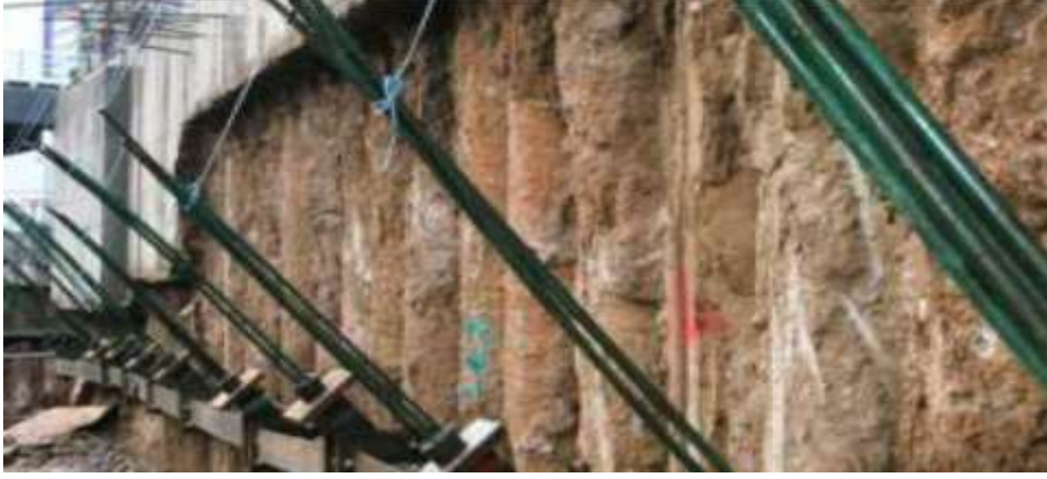
Şekil 1.33. Ankraj örnekleri
