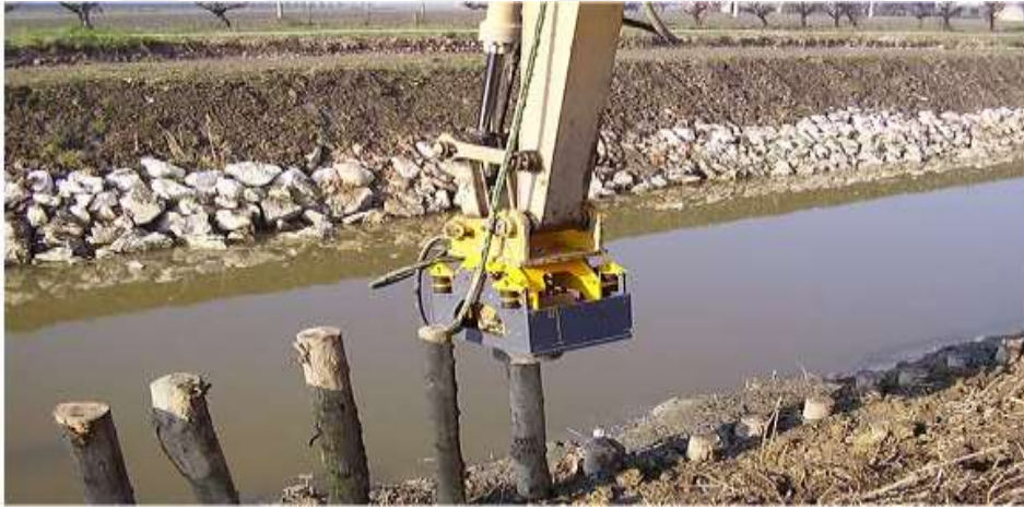
Şekil 1.34. Ahşap kazık uygulamasına ait bir örnek
