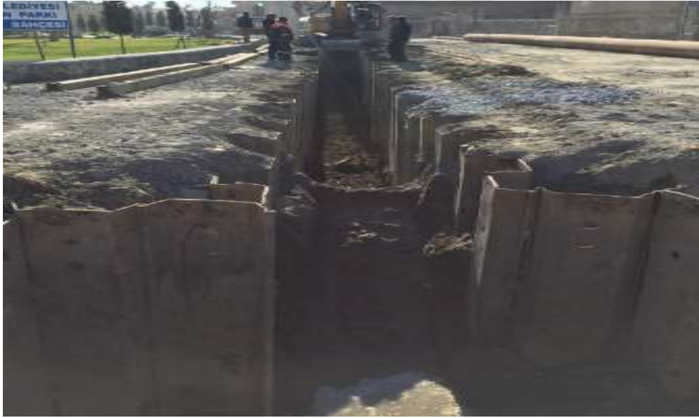
Şekil 1.41. Palplanş uygulaması
