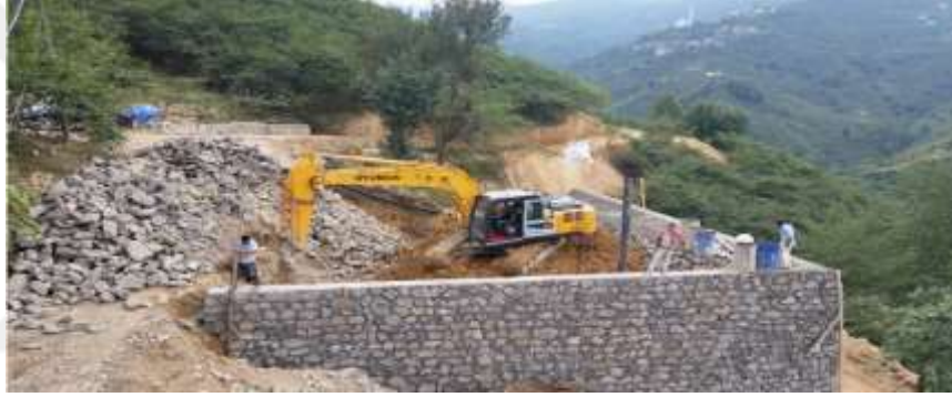
Şekil 1.30. Taş duvar örneği-inşaatı
