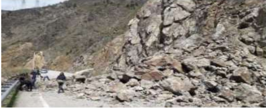
Şekil 1.8. Gümüşhane-Tirebolu yolunda düşme heyelanı
