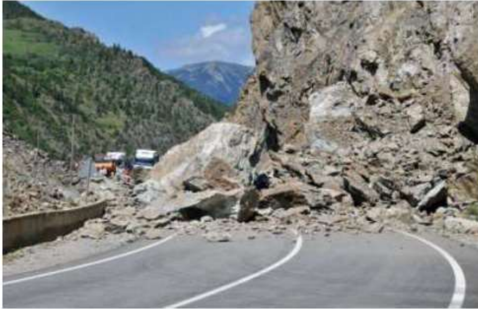
Şekil 1.10. Tirebolu-Torul yolunda gerçekleşmiş devrilme türü zemin hareketi
