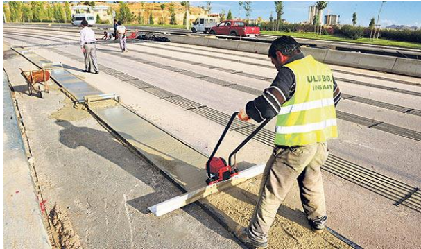
Şekil 10. Ankara protokol yolu üzerindeki elektrikli ısıtma kablosu uygulaması (URL-1,2020)
