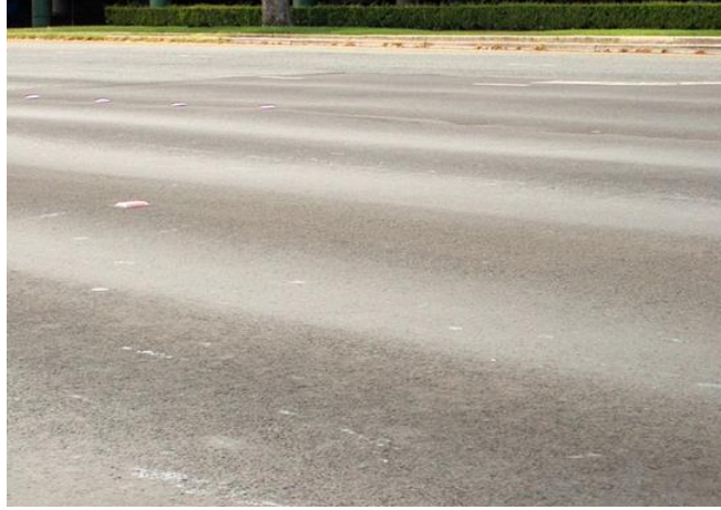
Şekil 3. Tekerlek izinde oturma (URL-2, 2020)
