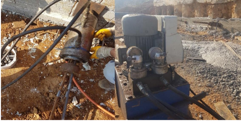
Şekil 1.13. Krikonun yerleştirilmesi ve güç ünitesi ile germe işlemi yapılması
