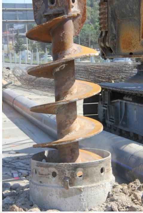
Şekil 1.3. Kılıflı fore kazık imalatı
