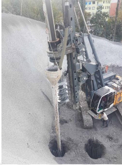
Şekil 1.2. Tremi borusu yardımıyla beton dökümü
