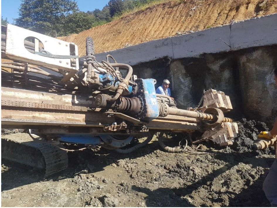
Şekil 1.11. Burgu ile ankraj delgisi işlemi
