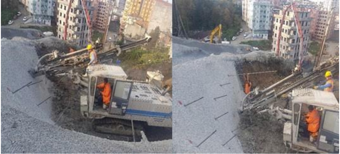
Şekil 1.15. Zemin çivisi imalatı
