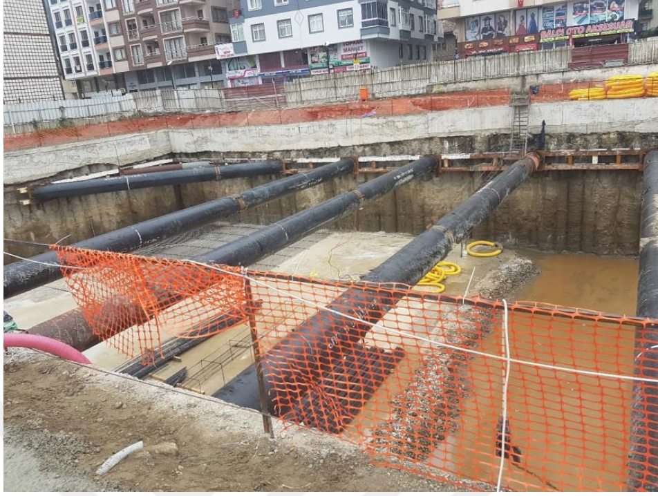
Şekil 1.14. Boru destek uygulaması
