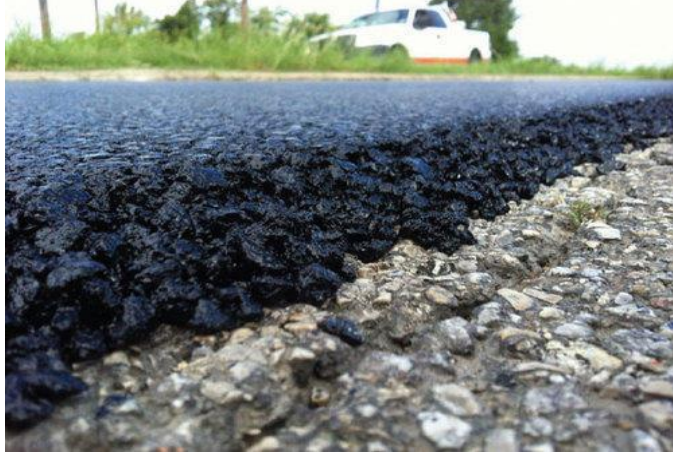
Şekil 37. Taş mastik asfalt (URL-8, 2021).
