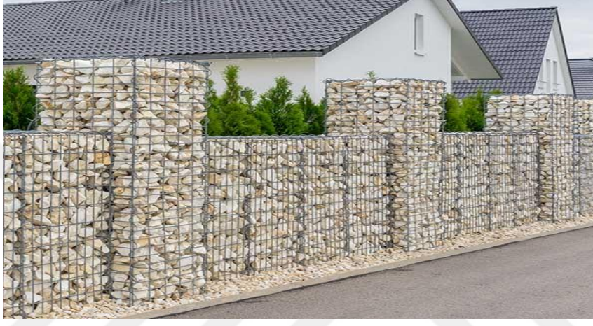
Şekil 24. Gabion duvarlar (URL-5,2021).
