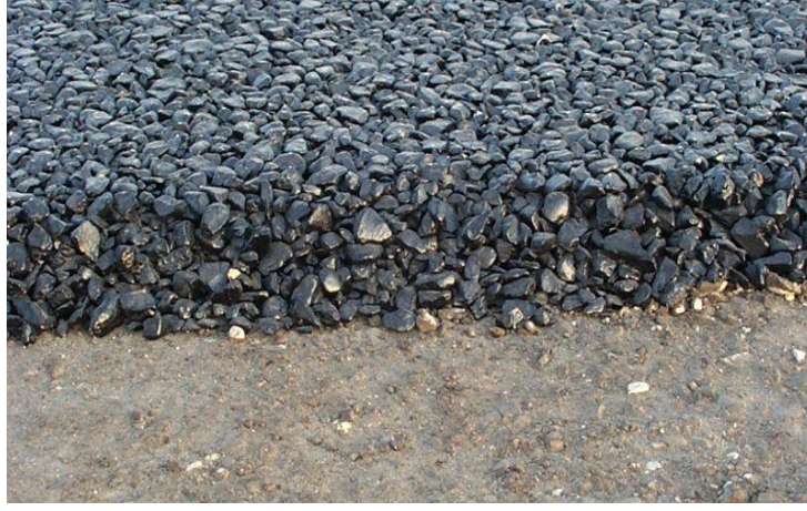
Şekil 29. Poroz asfalt kaplama (URL-7,2021).
