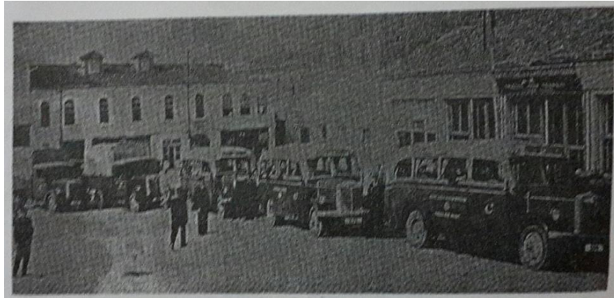
Fotoğraf 10: Eski Trabzon Otobüs Terminali
