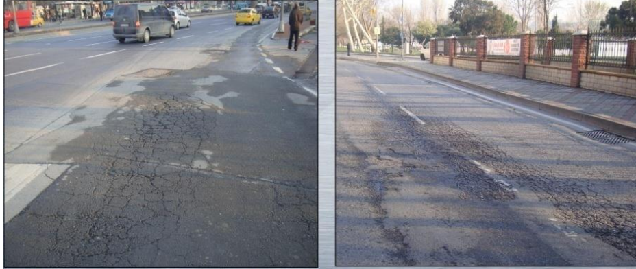
Şekil 1.14. Yorulma çatlakları [11].
