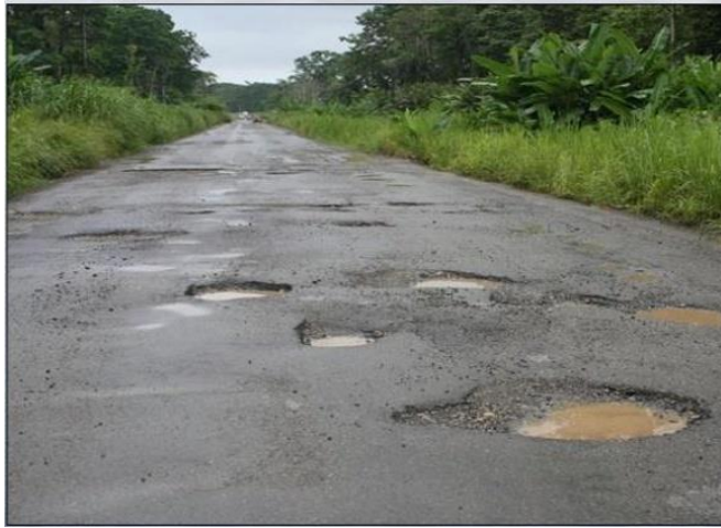
Şekil 1.23. Çukur-sökülme-soyulma [11].
