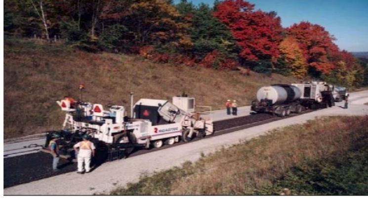
Şekil 2.22. Soğuk yerde geri dönüşüm uygulaması [18].
