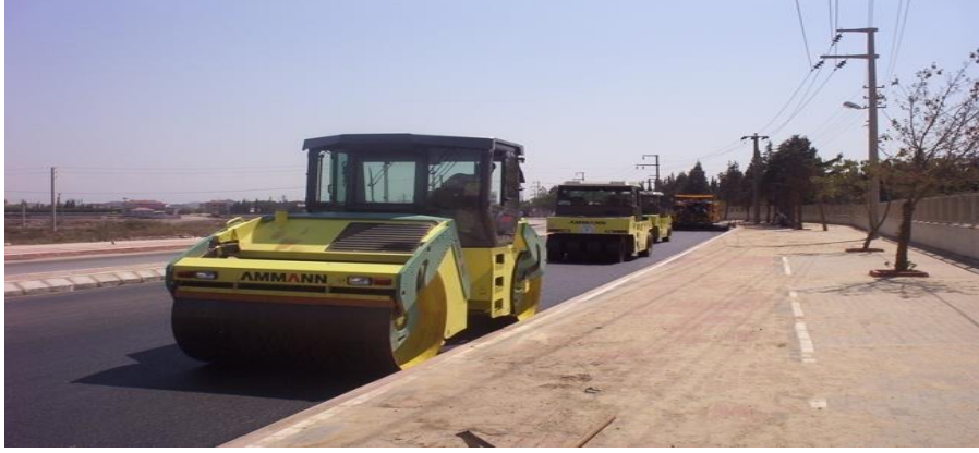
Şekil 1.10. Aşınma tabakası uygulaması [9].
