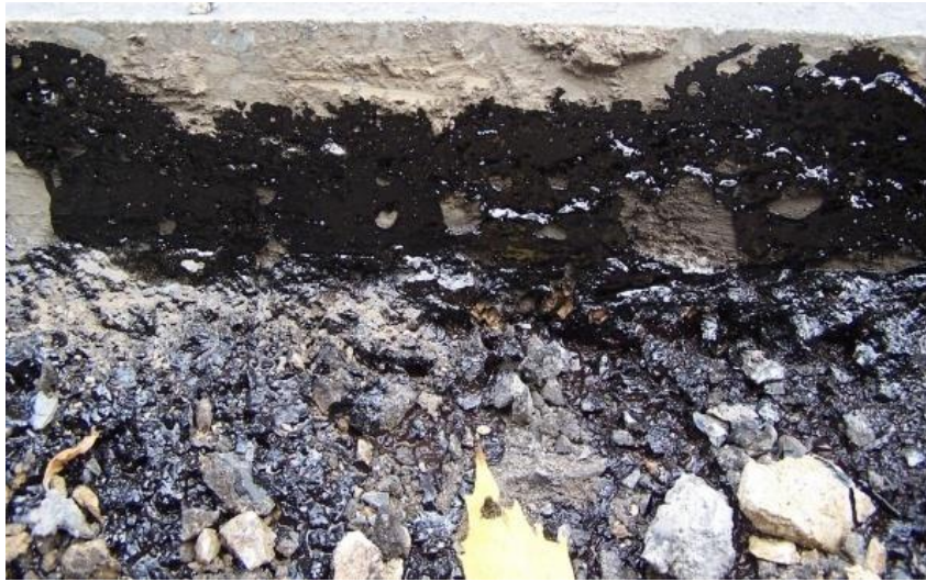
Şekil 1.13. Temizlenmeyen yüzey ve uygun olmayan emülsiyon uygulaması [37].
