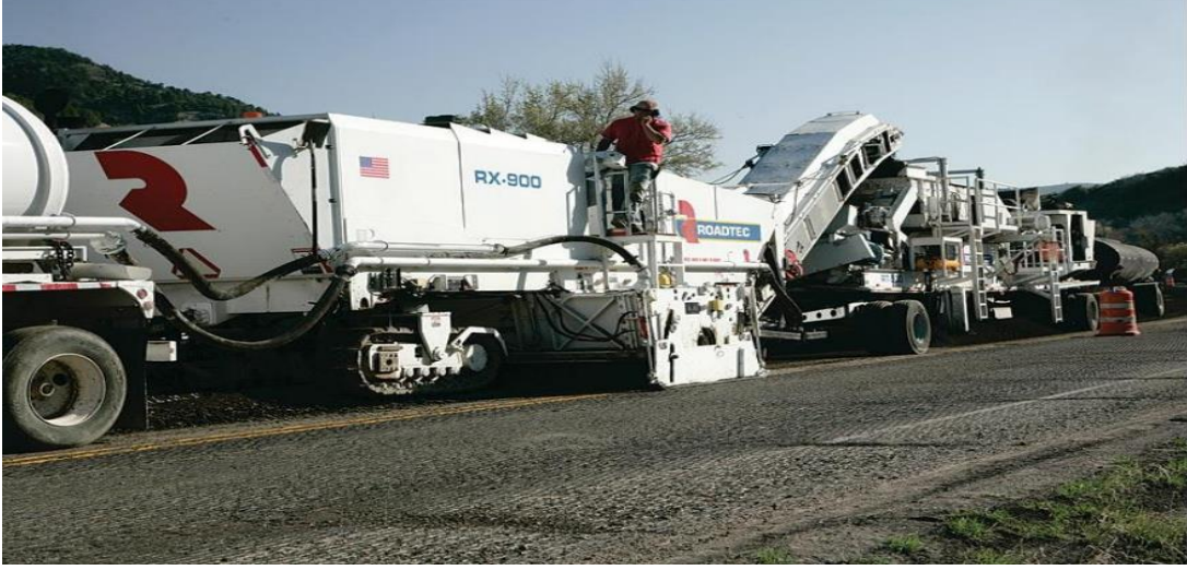
Şekil 2.20. Yerinde sıcak geri dönüşüm [20].
