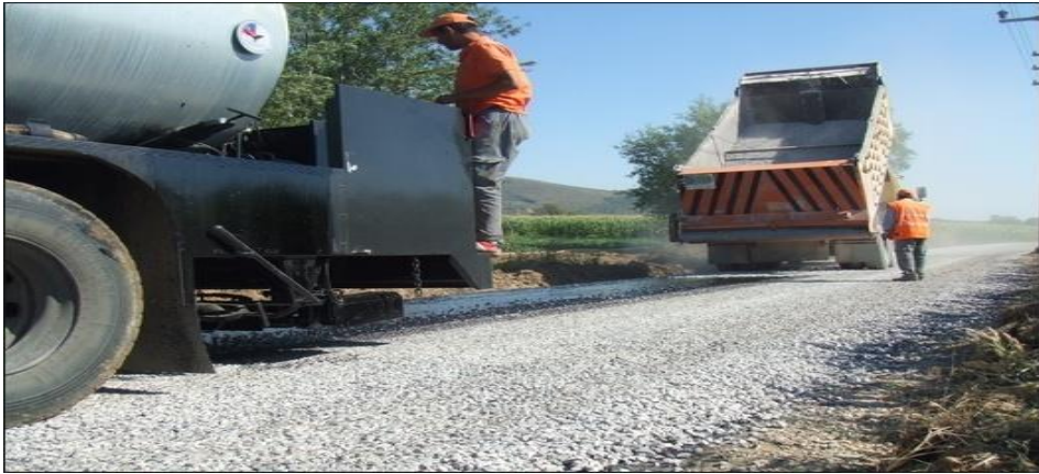
Şekil 1.12. Sathi kaplama uygulaması
